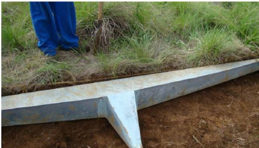
Figura 6. Fazer o ajuste fino no sentido lateral.
