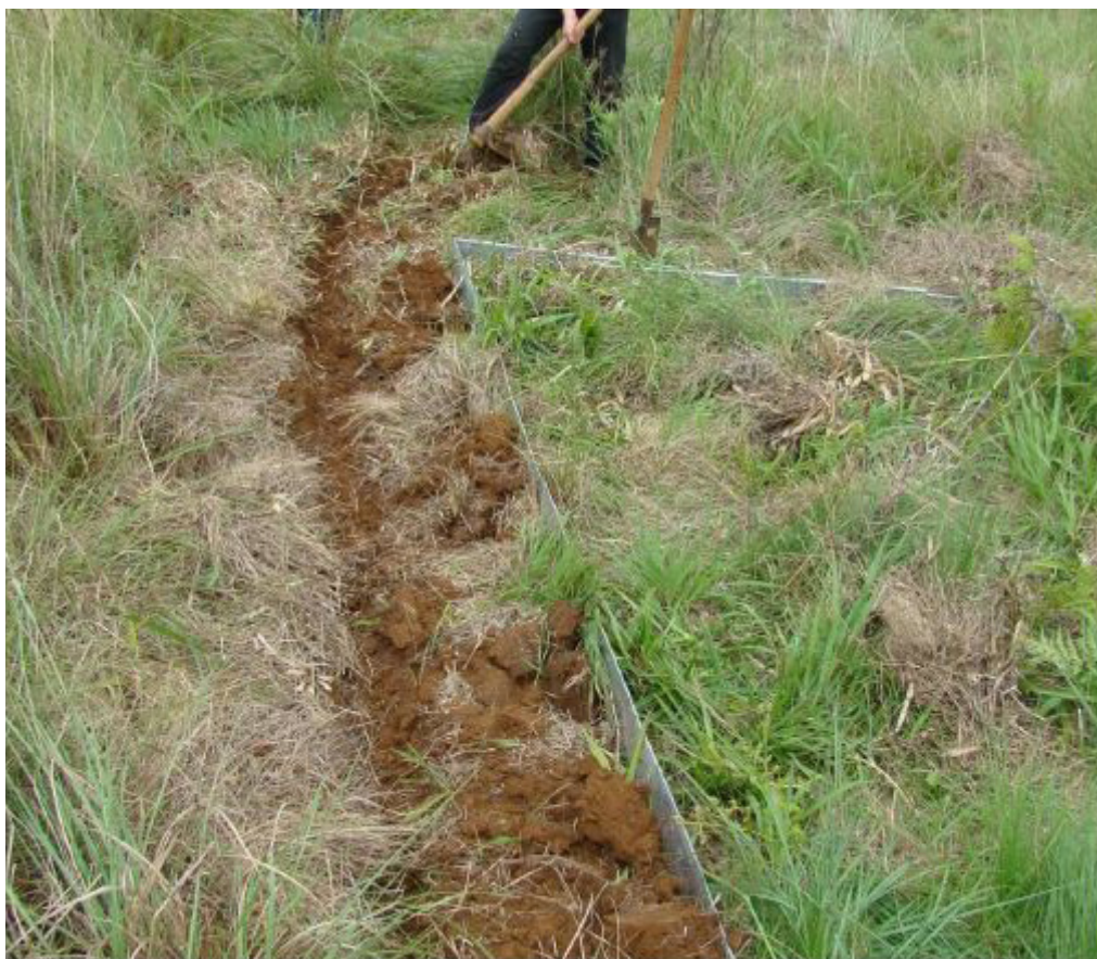
Figura 11. Valetamento, limpeza e achego de terra junto às paredes.
