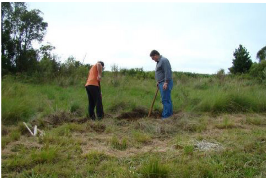
Figura 3. Eliminar a vegetação e limpar o local das paredes da parcela.
