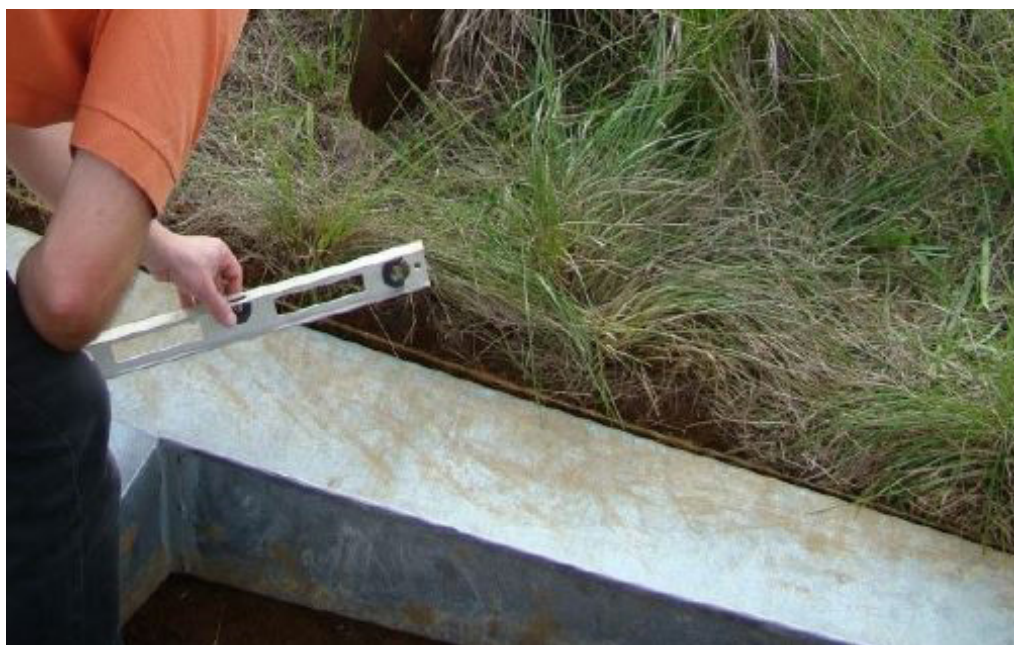
Figura 7. Nivelar e centralizar o coletor.
