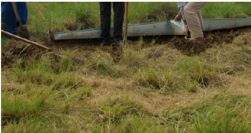
Figura 5. Acertar o coletor quanto aos desvios mais grosseiros de solo, utilizando solo que deve ser compactado, nunca pedras ou materiais orgânicos percíveis, principalmente, em trabalhos de longo prazo.
