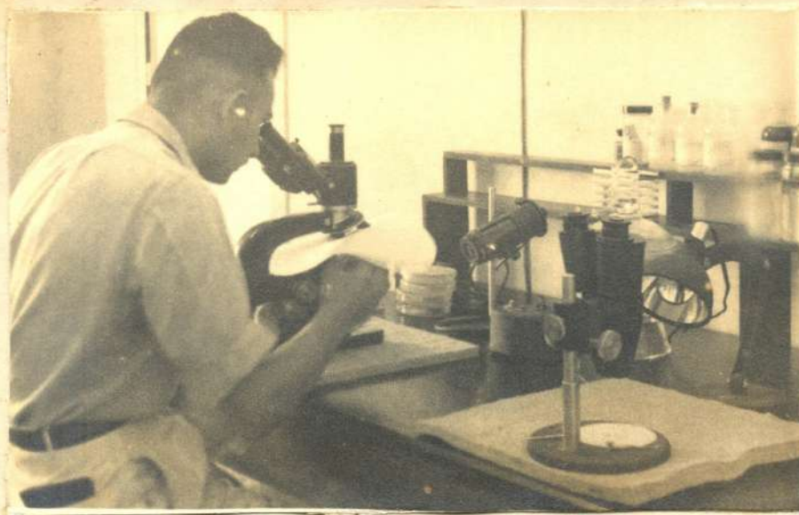
Fig. 45 - Coleta monoconfídica dom o microcoletor. Com a mão, o pperador, desloca convenientemente a placa de agar sobre a platina, protegida pelo disco de papel de filtro.
