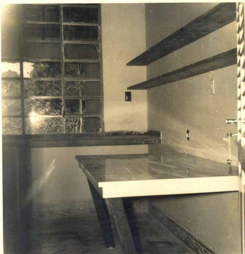
Fig.4 - Detalhe de um dos novos laboratórios em construção para o Programa de Entomologia. Sala de pesagem e microfotografia.
