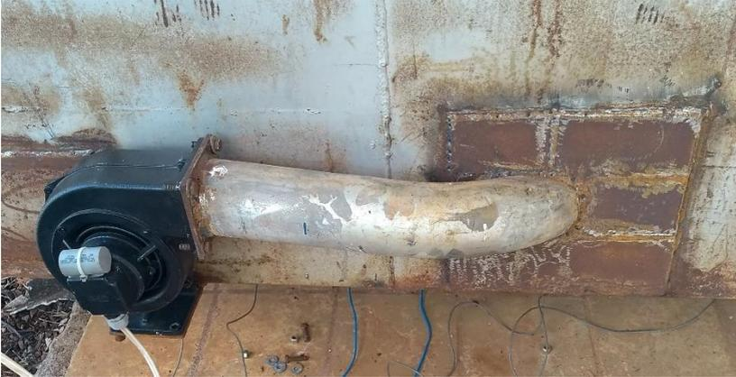
**Figura 4** – Detalhe da instalação do exaustor na câmara plenum. Foto: Roberta Martins Nogueira
