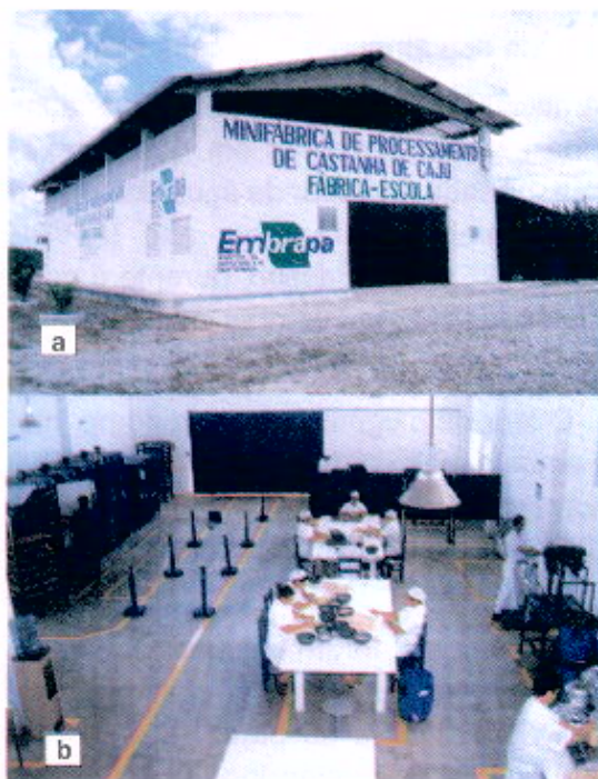
FIG. 26. Miniunidade de beneficiamento de castanha de caju - Fábrica-escola - (a) fachada; (b) interior.
