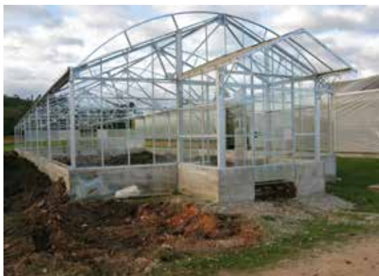
Recuperação da estrutura com a colocação de arcos metálicos e vista da parte posterior da estufa, já em utilização.
