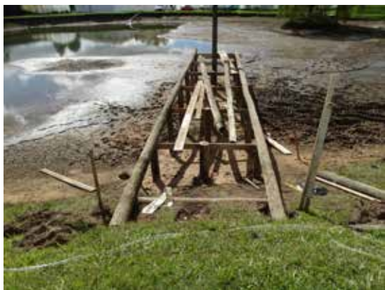
Colocação do madeiramento e dos pranchões: o trapiche tomava corpo.
