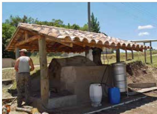
Produção do extrato pirolenhoso: forno concluído e detalhe da coleta do material resultante da condensação dos vapores da fumaça.
