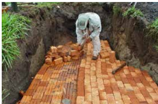
Forno para produção do extrato pirolenhoso em fase inicial da construção.
