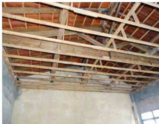
Interior do prédio do depósito em reforma, com a elevação do pé-direito e a troca do telhado.
