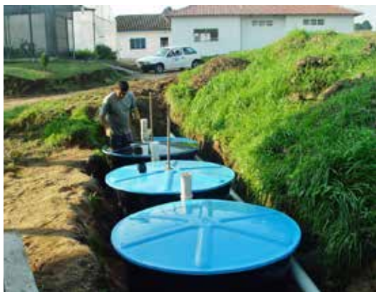
Reforma do prédio do vestiário de apoio ao campo da Estação em fase de conclusão e a instalação da fossa séptica biodigestora atendendo aos banheiros do prédio.
