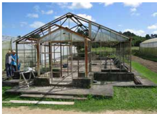
Início do processo de desmontagem da estufa.
