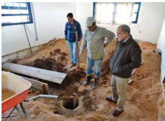
Obras de divisão do auditório: o estaqueamento para as futuras paredes.
