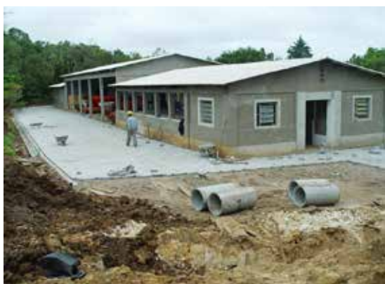
Etapas avançadas da pavimentação do entorno e do acesso à Central de Adubos Orgânicos.
