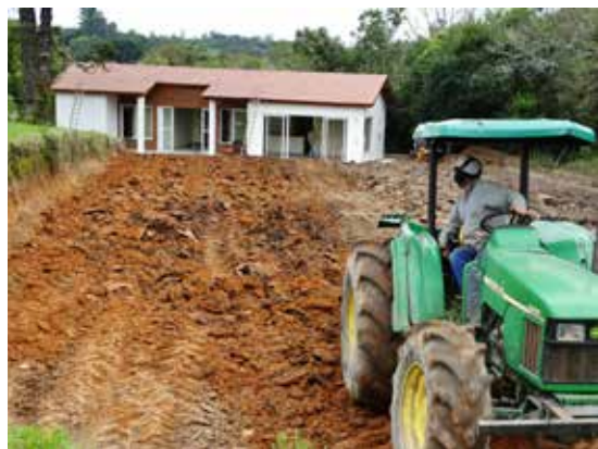
Preparo da área da cancha de futebol, com a colocação de terra vegetal para plantio da grama.
