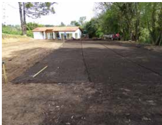
Preparo da área da cancha de futebol, com a colocação de terra vegetal para plantio da grama.
