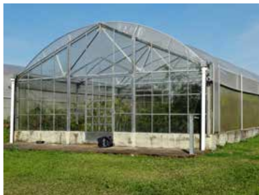
Recuperação da estrutura com a colocação de arcos metálicos e vista da parte posterior da estufa, já em utilização.
