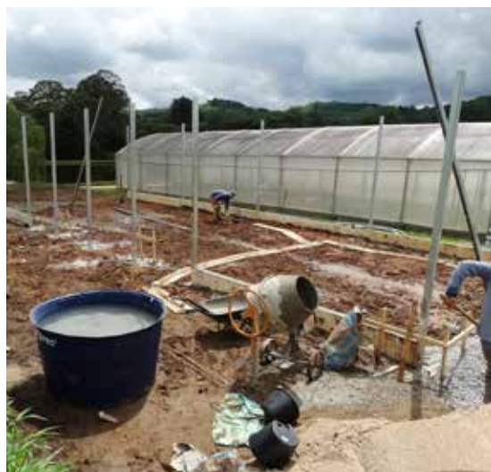
Fase inicial da construção da estufa plástica com ambiente controlado.
