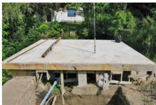
Etapas da construção da estrutura de bombeamento da água captada na barragem da Estação Experimental Cascata.
