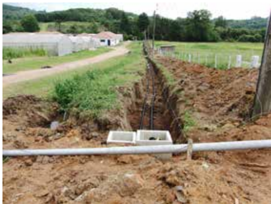
Cabeamento subterrâneo da rede lógica, telefônica e elétrica da Estação Experimental Cascata.
