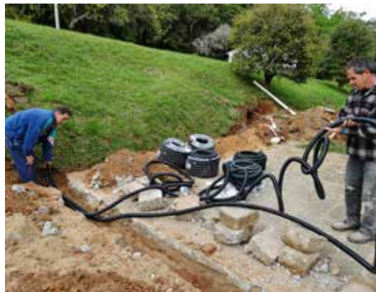
Cabeamento subterrâneo da rede lógica, telefônica e elétrica da Estação Experimental Cascata.
