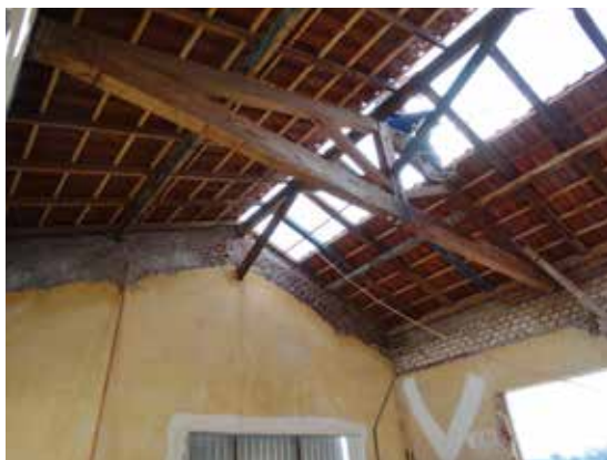
Interior do prédio do depósito em reforma, com a elevação do pé-direito e a troca do telhado.
