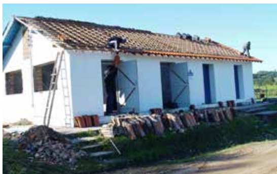
Visão externa da reforma da biofábrica: a troca do telhado.
