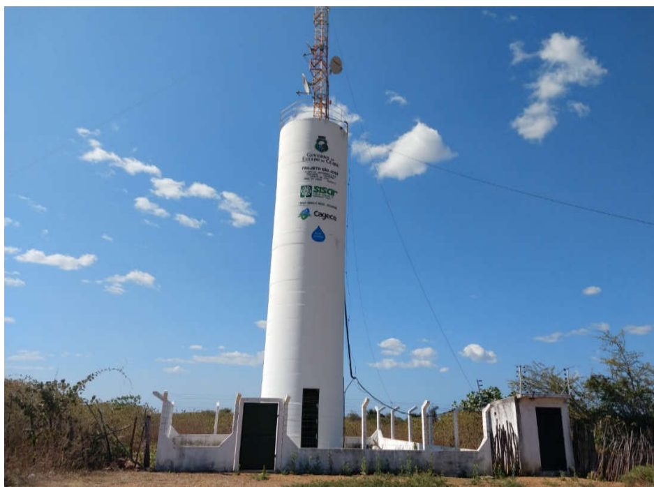
Figura 21 – Reservatório elevado na localidade de Serra dos Vieiras, município de Russas (CE)
