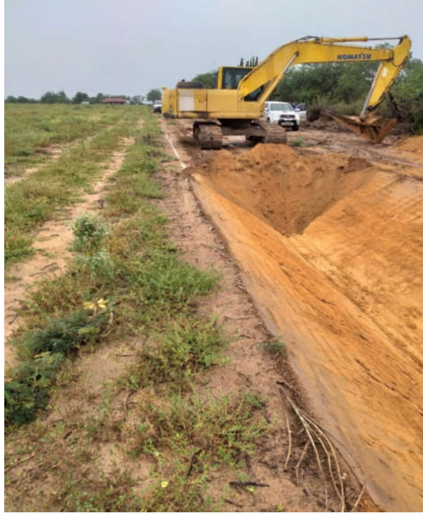
Figura 3 – Implantação de dreno coletor no Projeto Pontal Sul
