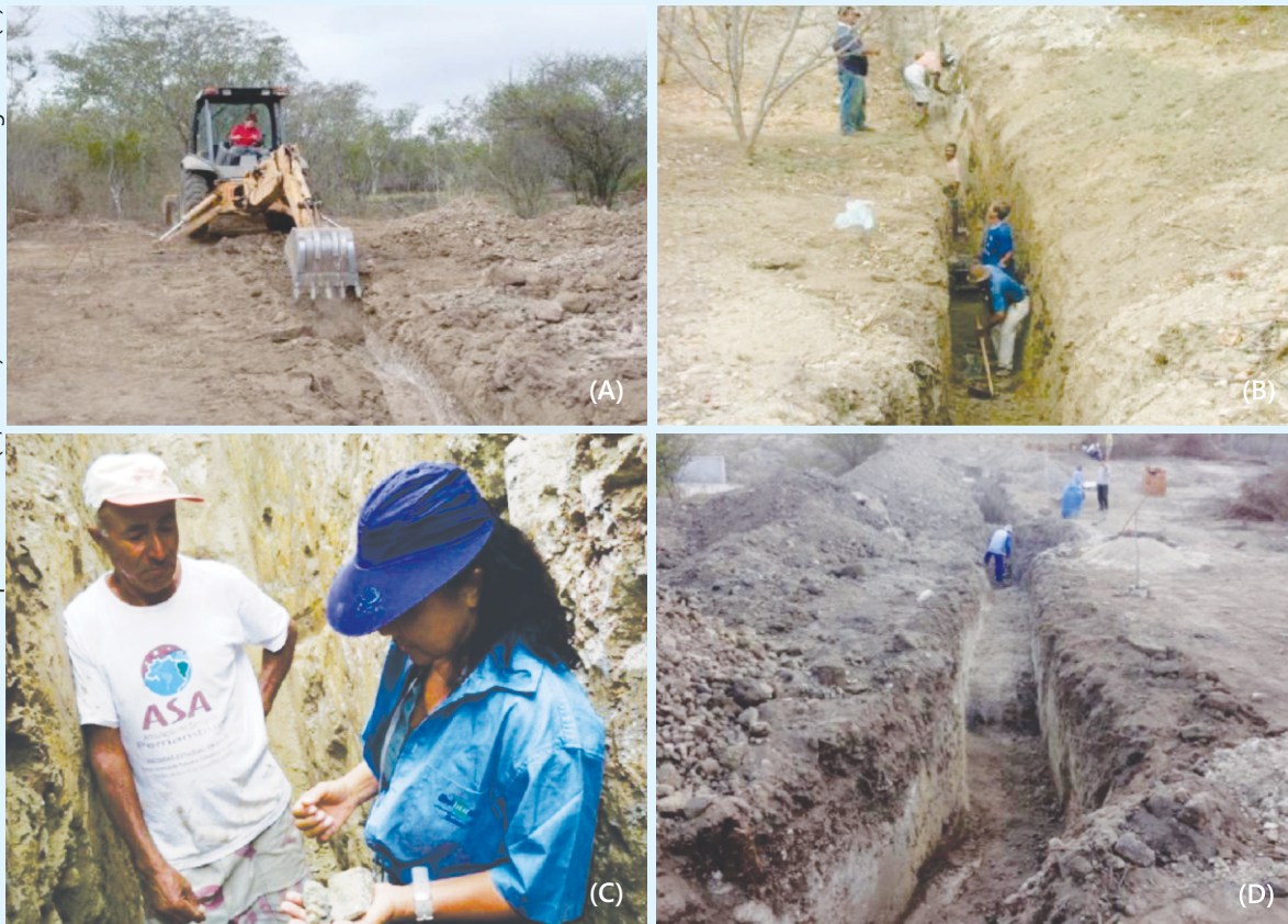
Figura 13. Abertura com retroescavadeira (A); abertura manual (B); exame das características do solo; acabamento da abertura da vala (D).
