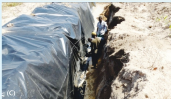
Figura 15. Desenrolamento do plástico (A); estiramento do plástico (B); chumbamento do plástico no fundo da vala, na minevaleta (C); vala com plástico estendido (D).
