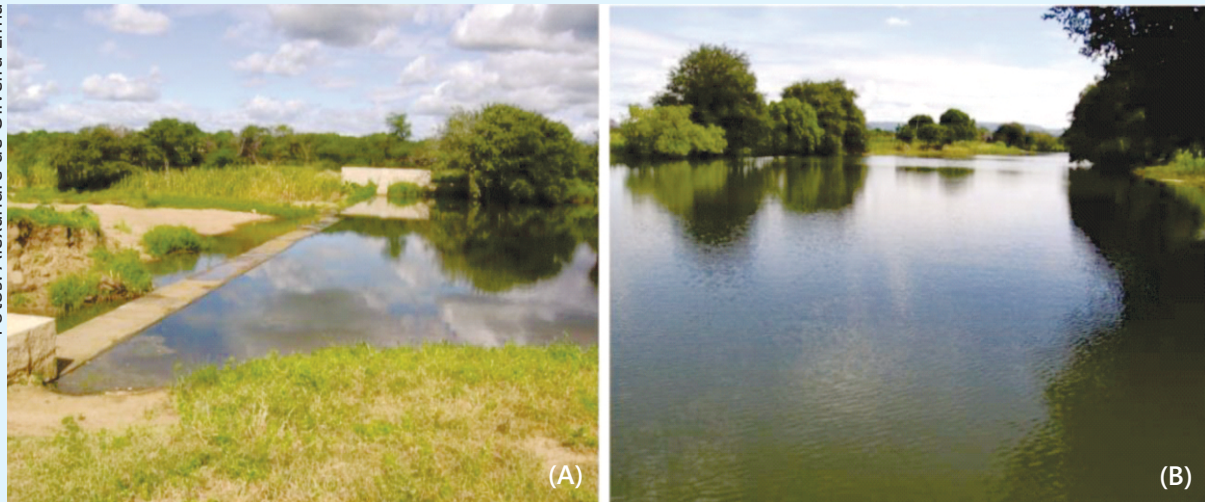
Figura 9. Barragem subterrânea submersível modelo Serra Negra do Norte (A); barragem subterrânea submersível modelo Serra Negra do Norte, mostrando detalhe do lençol d'água formado após chuvas (B).
