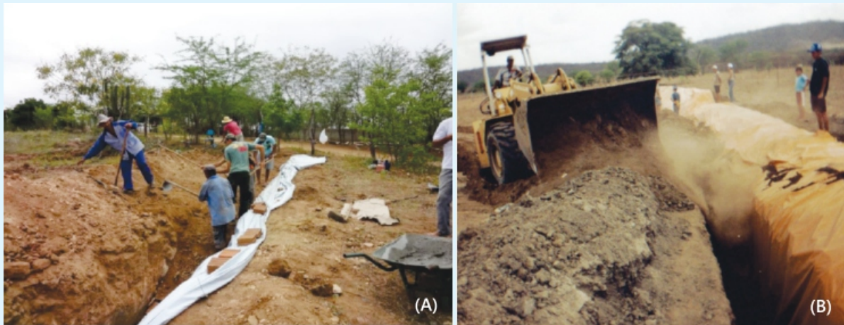
Figura 16. Fechamento da vala por meio de mutirão de agricultores (A); fechamento com máquina (B).
