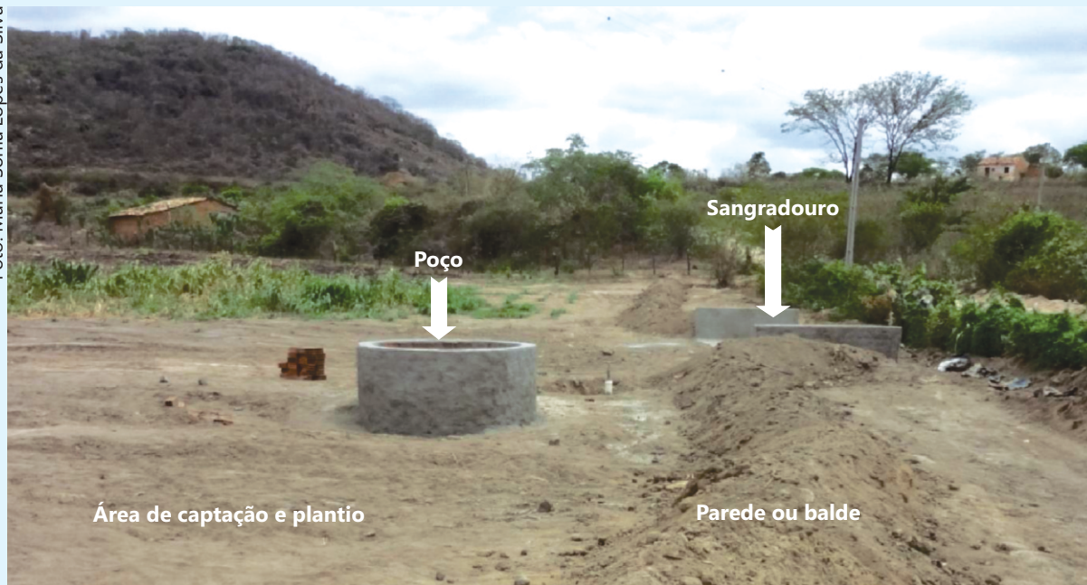
Figura 18. Barragem subterrânea submersível finalizada com todos os seus componentes.
