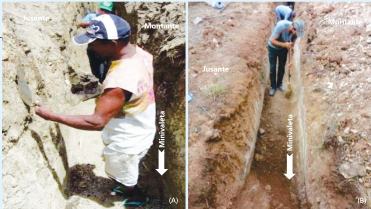
Figura 14. Limpeza da parede, reboco de alguns locais e detalhe da minivaleta (A); varrição do fundo da vala e detalhe da minivaleta (B).
