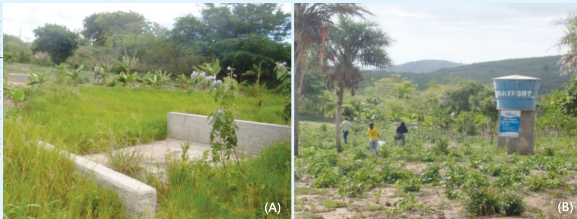
Figura 8. Barragem subterrânea submersível modelo ASA com detalhe do sangradouro (A); barragem subterrânea submersível modelo ASA com detalhe da caixa-d'água (B).
