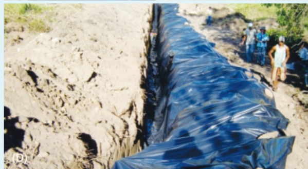
Figura 15. Desenrolamento do plástico (A); estiramento do plástico (B); chumbamento do plástico no fundo da vala, na minevaleta (C); vala com plástico estendido (D).
