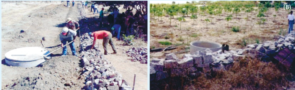
Figura 7. Barragem subterrânea submersa modelo Costa & Melo com detalhe do poço e proteção da parede (A); barragem subterrânea submersa modelo Costa & Melo com produção de mandioca (B).
