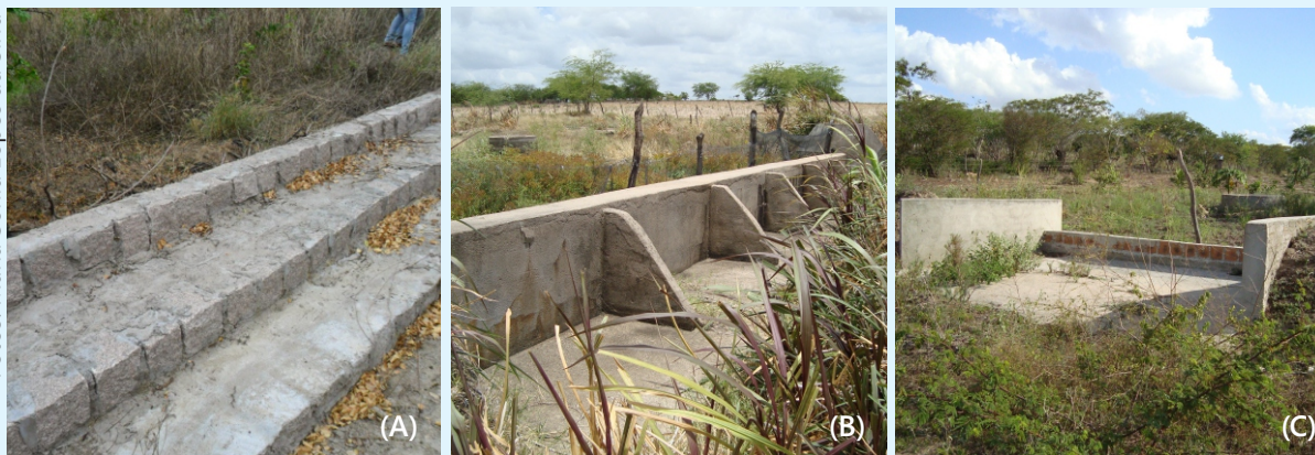
Figura 17. Sangradouros com diferentes modelos de como escoar a água à jusante: degraus (A); escoras de sustentação (B); calçada/rampa (C).
