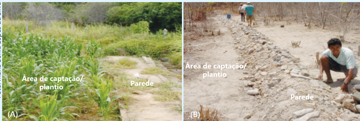
Figura 4. Barragem subterrânea submersa com proteção da parede de alvenaria (A); barragem subterrânea submersa onde a proteção da parede é com solo e pedra (B).
