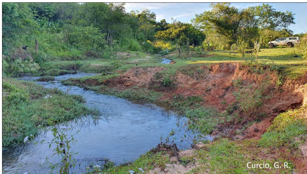
Figura 2 - Margem Fluvial destituída de floresta ciliar, severamente erodida
