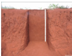
Figura 5 – Perfil em talude de estrada
