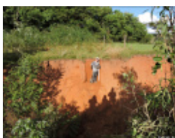
Figura 6 – Perfil em talude de voçoroca
