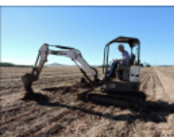
Figura 8 – Perfil sendo aberto por máquinas
