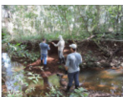
Figura 4 – Perfil em talude fluvial
