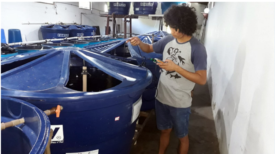
Figura 1. Caixas de PVC utilizadas como unidades de criação no Sistema de Recirculação de Água (SRA).
