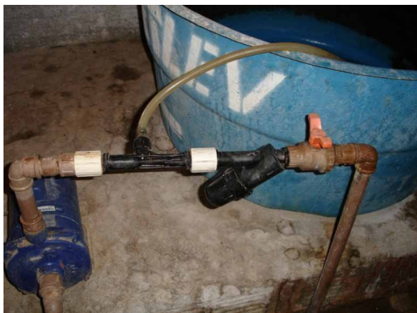
Figura 8. Instalação de Venturi utilizando bomba auxiliar (à esquerda).
