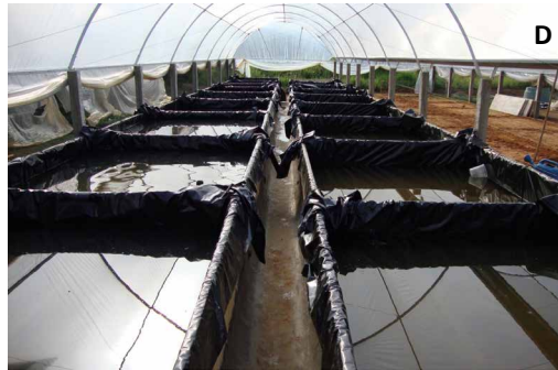
Figura 51. Tanques de placas de concreto: montagem da forma das placas (A); placas prontas nos moldes de fabricação (B); sistema de drenagem em tanque com forração de lona (C); vista panorâmica da estufa com corredor servindo de valeta de drenagem (D).
