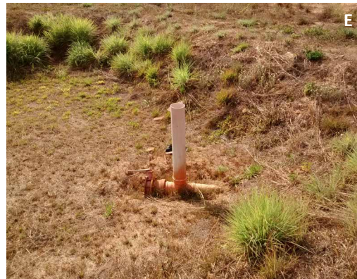
Figura 31. Sistemas de drenagem de viveiros escavados: cachimbo externo em tubo de 150 mm (A); cachimbo interno em tubo de 150 mm (B); ladrão em estrutura de alvenaria com tubo de drenagem (C); valeta de drenagem de água de viveiros em piscicultura (D); vista externa de drenagem com cachimbo e registro (E).
