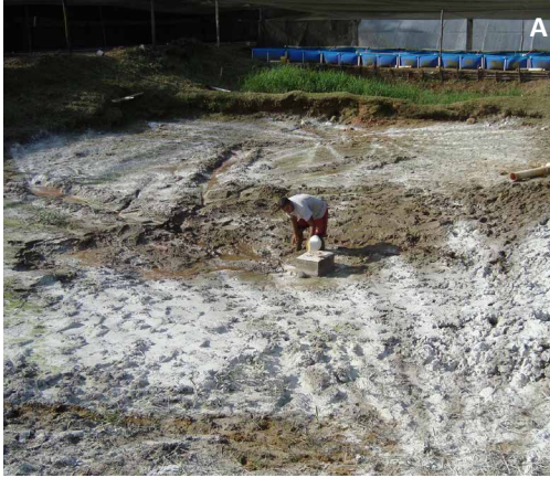
Figura 34. Sistema de drenagem: base do monge ou do cachimbo dentro do viveiro com reforço em alvenaria (segurança adicional para reduzir risco de o cachimbo se soltar) (A); vista lateral da base do monge ou do cachimbo (B).
