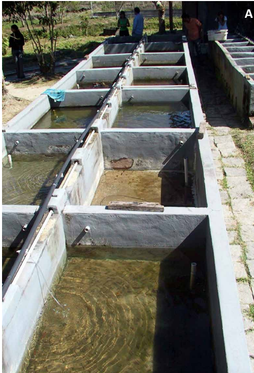
Figura 49. Tanques de alvenaria: tanques retangulares com drenagem pelo vértice externo e tubulação de aeração pelo centro (A); tanques retangulares com sistemas de abastecimento, drenagem e aeração individualizados em ambiente protegido por tela anti-insetos (B); tanques retangulares de blocos de concreto e revestido com lona (C).
