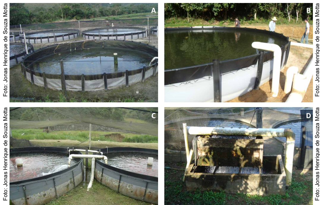
Figura 55. Tanques de vinilona: área protegida com tela anti-insetos e tanques de engorda de ciprinídeos (A); sistema de abastecimento e drenagem em fase de instalação (B) e após montagem (C); sistema de abastecimento em fase de produção (D).
