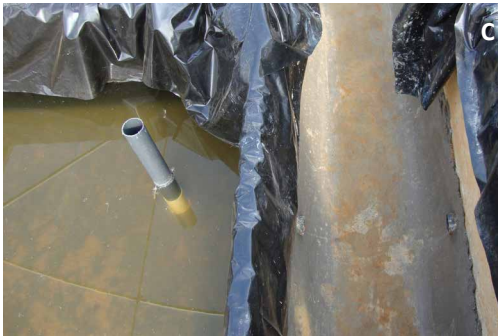
Figura 51. Tanques de placas de concreto: montagem da forma das placas (A); placas prontas nos moldes de fabricação (B); sistema de drenagem em tanque com forração de lona (C); vista panorâmica da estufa com corredor servindo de valeta de drenagem (D).
