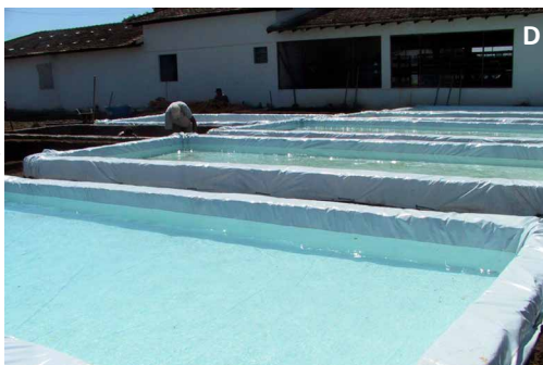
Figura 42. Etapas de construção de tanques de terra: terreno sendo preparado para implantação de tanques revestidos (A); solo escavado (B); preparação dos tanques com reboco interno de terra e ajustes das bordas (C); tanque com lona aplicada e cheio de água (D).
