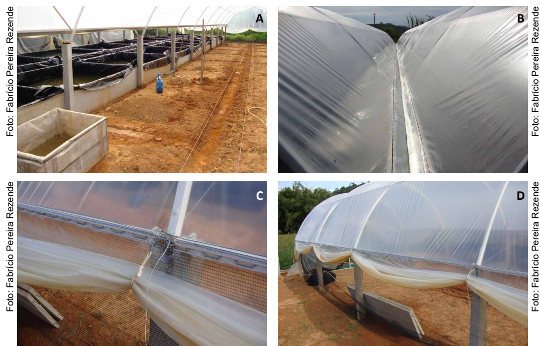
Figura 64. Vista geral de uma estufa e marcação interna da posição das placas de concreto que vão compor os tanques (A); sistema de drenagem de chuva entre estufas geminadas (B); canaleta de alumínio para fixação de lona com mola e ponto de fixação de cortina lateral (C); vista da lateral de estufa com a cortina suspensa e tela sombrite já instalada antes da montagem dos tanques de concreto (D).
