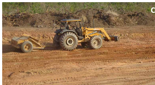
Figura 20. Etapas de preparação do terreno para implantação de estruturas de uma piscicultura: terreno após limpeza e terraplanagem (A); terreno antes da retirada de tocos, pedras e terraplanagem (B); trator de pneu com lâmina frontal e scraper na preparação do terreno (C).
