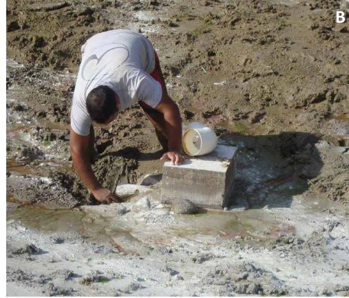
Figura 34. Sistema de drenagem: base do monge ou do cachimbo dentro do viveiro com reforço em alvenaria (segurança adicional para reduzir risco de o cachimbo se soltar) (A); vista lateral da base do monge ou do cachimbo (B).
