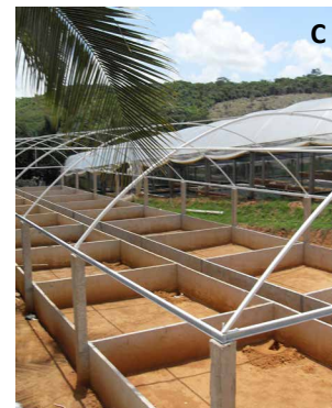
Figura 50. Tanques de placas de concreto: fase de montagem dos tanques com as placas de concreto (A); detalhe de instalação de dreno pelo fundo antes de forração com a lona (B); vista panorâmica da uma estufa e tanques em fase de montagem (C).
