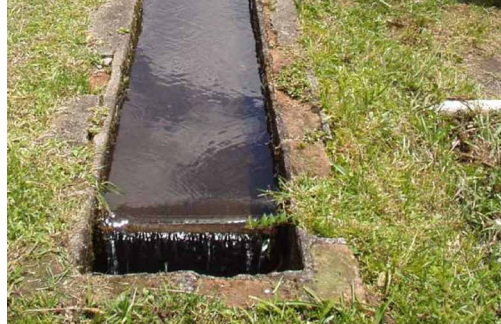
Figura 26. Sistema de abastecimento de água. Viveiros revestidos com lona e tubulação de distribuição enterrada: entrada de água individual e 0,30 m acima da água (A1); grama em volta dos viveiros para proteção na área de cultivo (A2); borda livre de 0,30 m (A3); talude que separa os viveiros e permite acesso (A4); canaletas de alvenaria e tubulação de derivação de água para os tanques de alvenaria (B, C, D e E); filtro de tela no controle de predadores (C1); entrada de água individual e com altura suficiente para aeração (C2).
