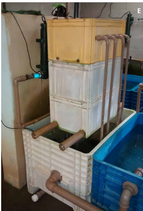
Figura 61. Filtro biológico: com mídias fluidizáveis compostas por recortes de conduítes com 30 mm (A); com mídias de nanoesferas em camadas semi-inundadas ou dry-wet (B); filtro rizosférico (C); detalhe da drenagem do filtro rizosférico para o tanque de abastecimento (D); filtro dry-wet (E); detalhe de compartimento com lã filtrante no filtro dry-wet (F).
