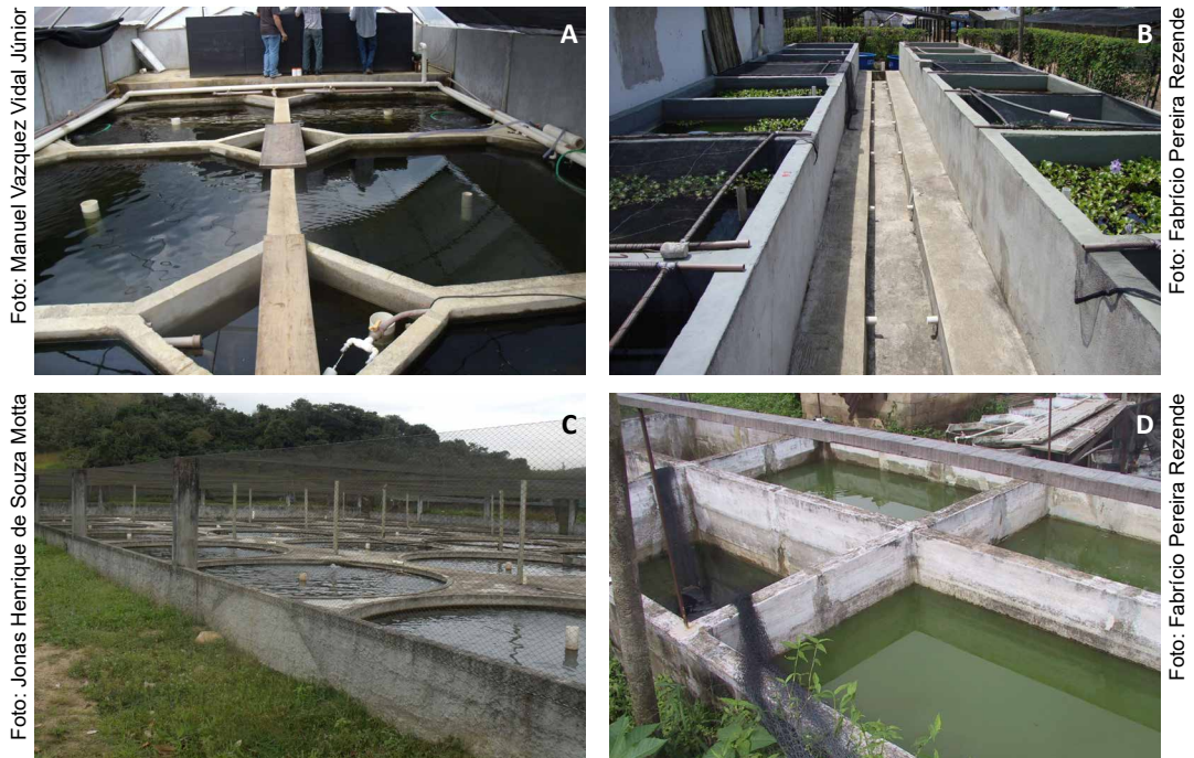
Figura 47. Tanques de alvenaria: estufa com tanques hexagonais, sistema de drenagem por caixa central, abastecimento pela lateral interna e drenagem pelo fundo (A); tanques retangulares com abastecimento pela lateral externa e drenagem pelo fundo com valeta de escoamento entre as fileiras de tanques (B e D); tanques circulares com abastecimento pelas laterais e escoamento pelo centro ao fundo, em ambiente suspenso e protegido por tela antipássaros (C).
