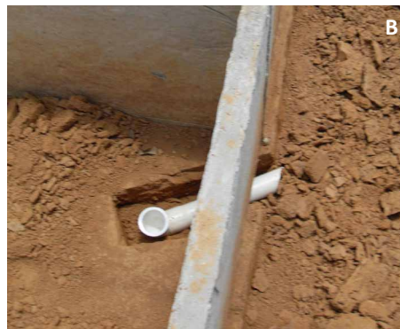
Figura 50. Tanques de placas de concreto: fase de montagem dos tanques com as placas de concreto (A); detalhe de instalação de dreno pelo fundo antes de forração com a lona (B); vista panorâmica da uma estufa e tanques em fase de montagem (C).
