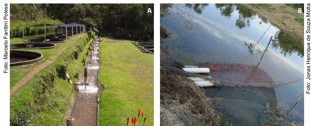
Figura 33. Sistemas de drenagem: valeta de drenagem e sequência de tanques circulares com cachimbo externo (A); rede de contenção em valeta de drenagem de sistema de despesca em viveiros (B).
