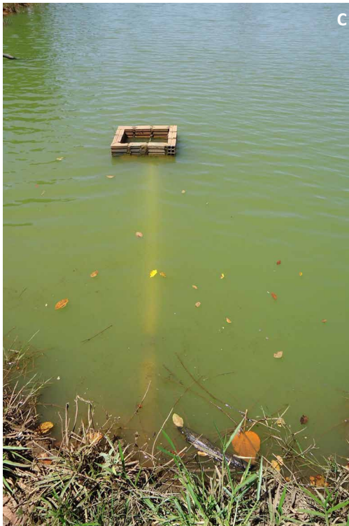
Figura 31. Sistemas de drenagem de viveiros escavados: cachimbo externo em tubo de 150 mm (A); cachimbo interno em tubo de 150 mm (B); ladrão em estrutura de alvenaria com tubo de drenagem (C); valeta de drenagem de água de viveiros em piscicultura (D); vista externa de drenagem com cachimbo e registro (E).
