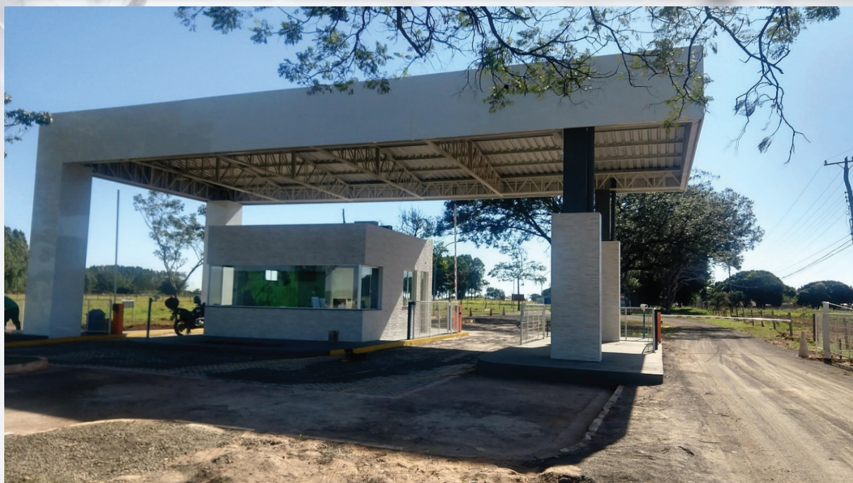
Figura 6. Reforma e ampliação da Guarita de Acesso.
