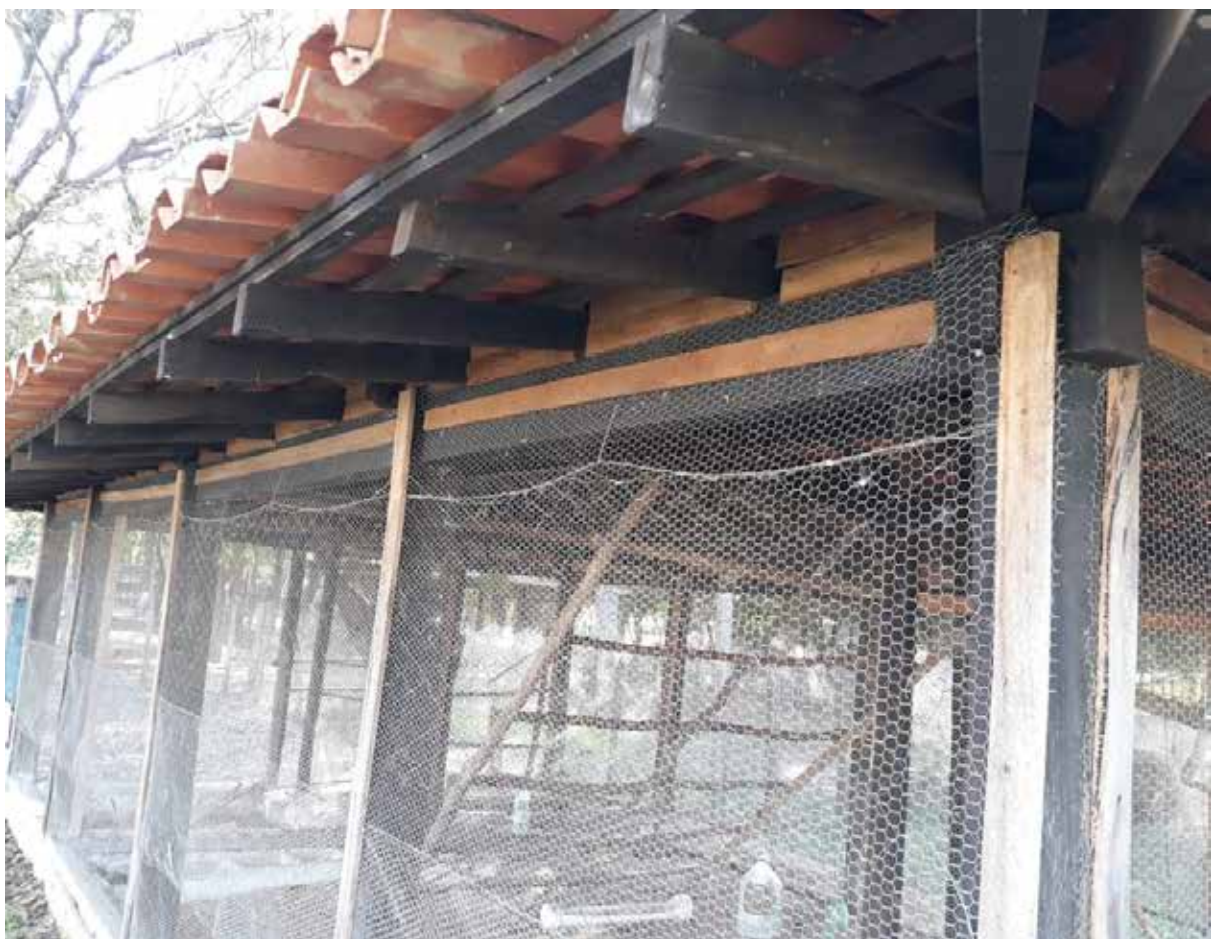
Figura 2. Telamento de galinheiro com estrutura de vedação tapando frestas
