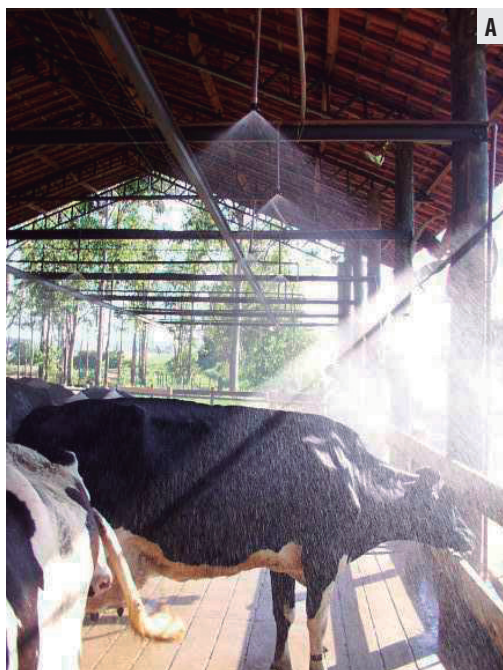
Figura 6. Sistema de resfriamento evaporativo por aspersão (A) e nebulização (B).
