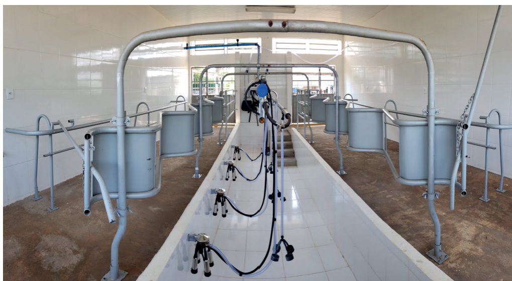
Figura 1. Sala de ordenha mecânica canalizada.
