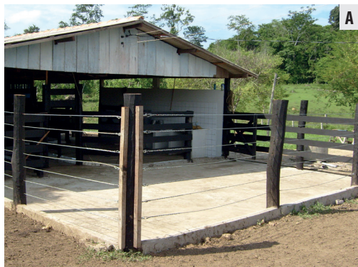
Figura 1. Curral de espera com piso de cimento e cerca de madeira e cordoalha (A); e outro com piso de blocos de concreto e cerca de concreto e cordoalha (B).
