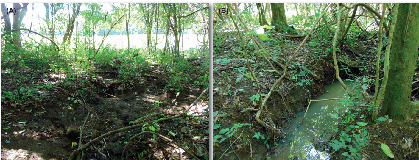
Figura 14. Aspecto da floresta e dos sulcos de erosão na área (A) e surgência hídrica localizada em Plintossolo Pétrico do ponto 7 (B).
