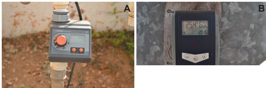
Figura 9. Equipamentos utilizados no telado de multiplicação e caracterização de acessos de Capsicum : A) Computador para programar a irrigação; B) Datalogger para registrar as condições ambientais.
