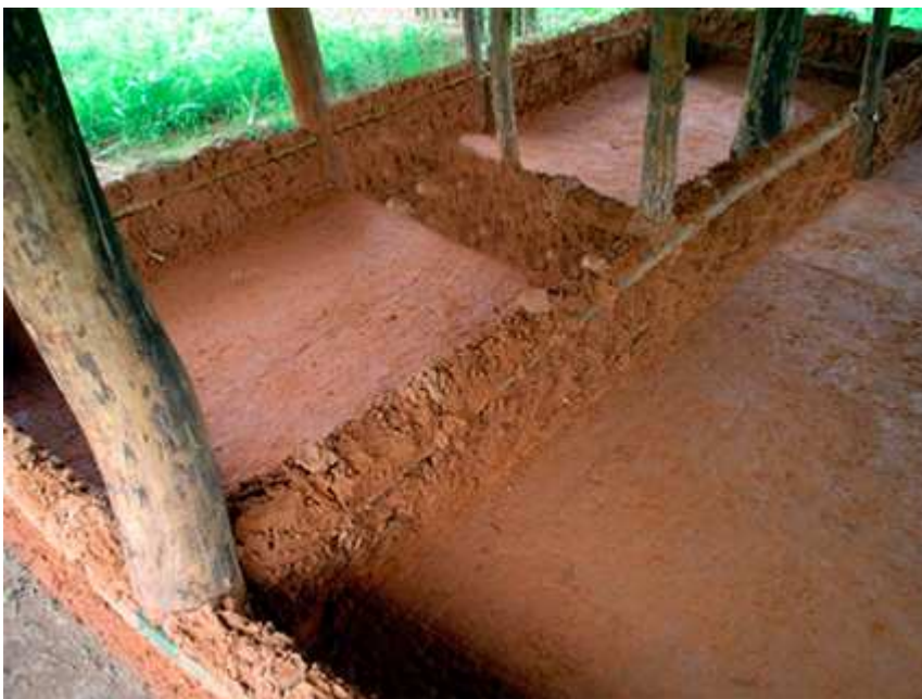
Figura 13. Piso revestido com barro compactado.
