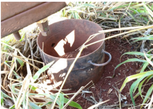
Figura 17. Limpeza do local para instalação do anel metálico.
