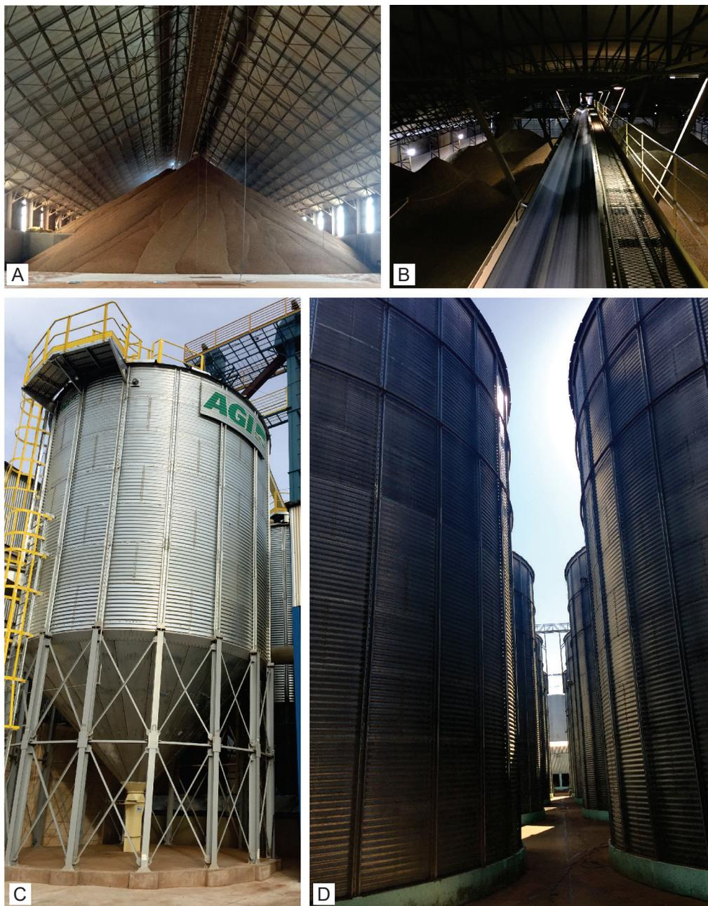
**Figura 12.** Armazenamentos de amendoim a granel em galpões (A, B) e em silos verticais (C, D).
