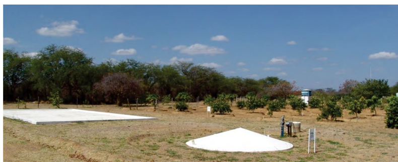
Figura 1 – Cisterna calçadão, área de captação e pomar instalados na área experimental da Embrapa Semiárido
