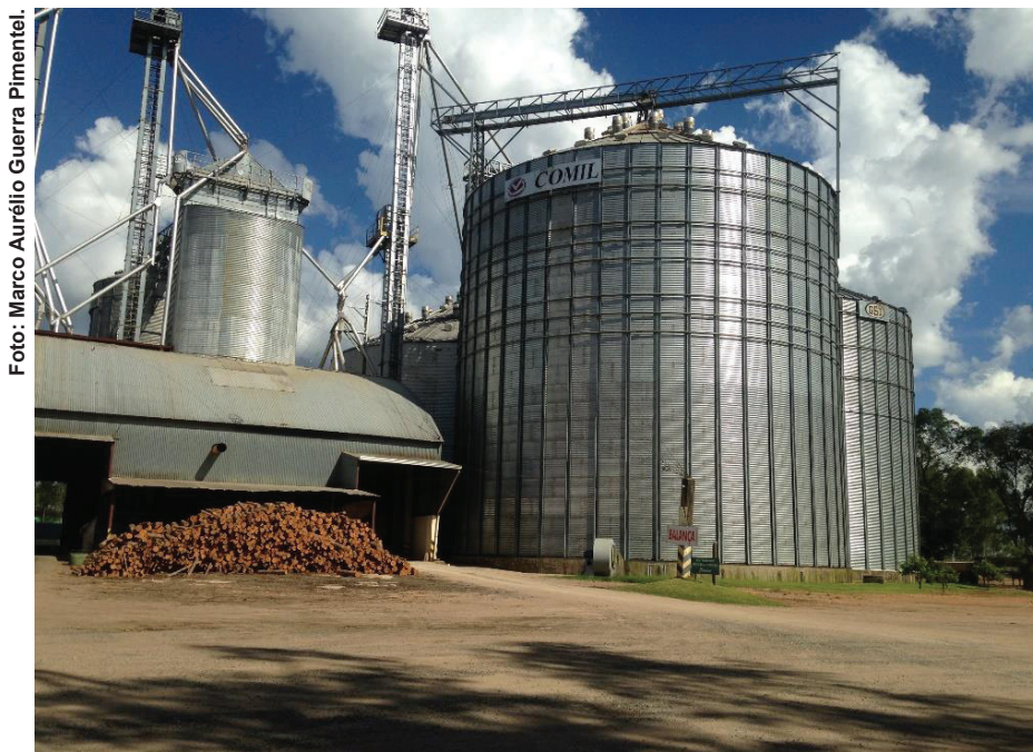
Figura 19. Silo metálico para armazenamento de grãos de sorgo a granel.
