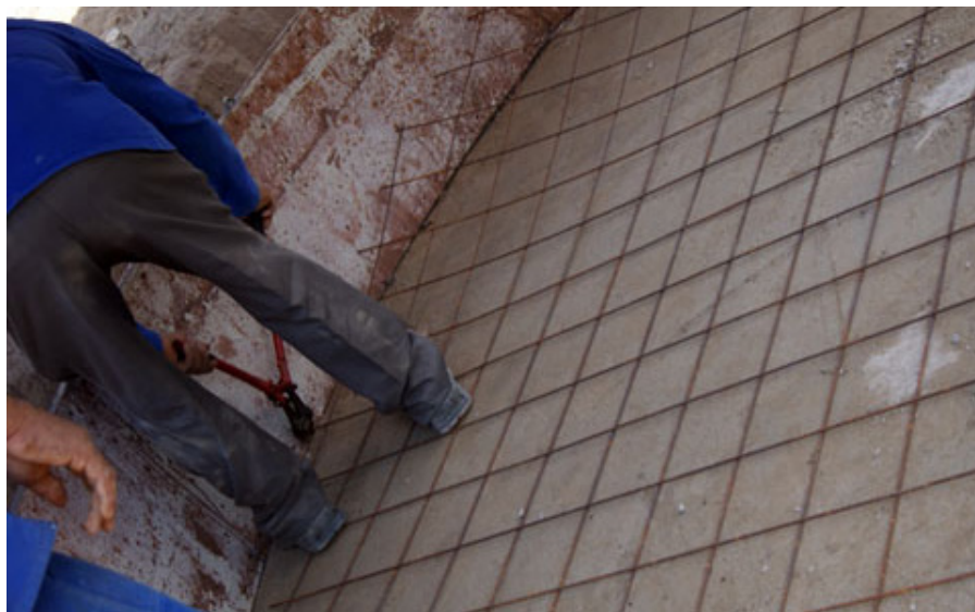
Figura 17. Distribuição da tela de ferro sobre o contrapiso com a forma externa montada.
