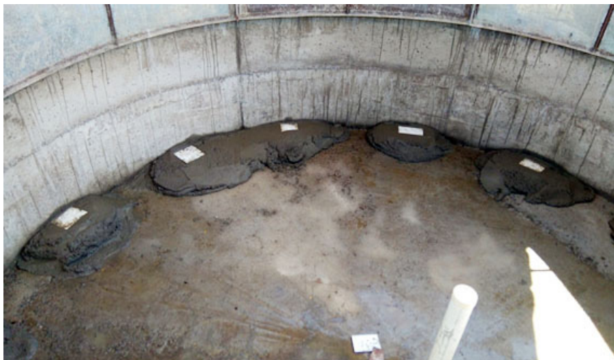
Figura 36. Marcação do piso do tanque para a operação de acabamento.
