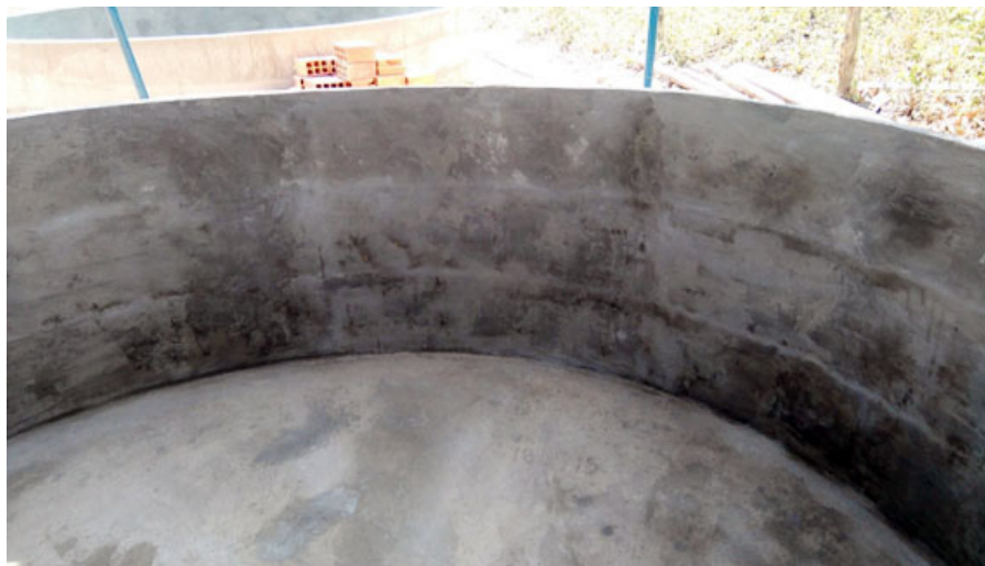
Figura 40. Tanque após impermeabilização da parede interna.
