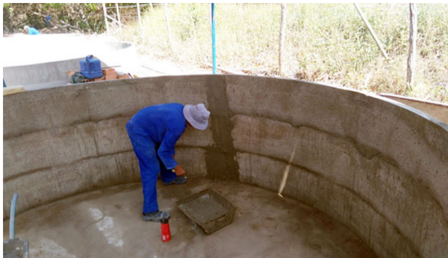
Figura 39. Início da operação de impermeabilização da parede interna.
