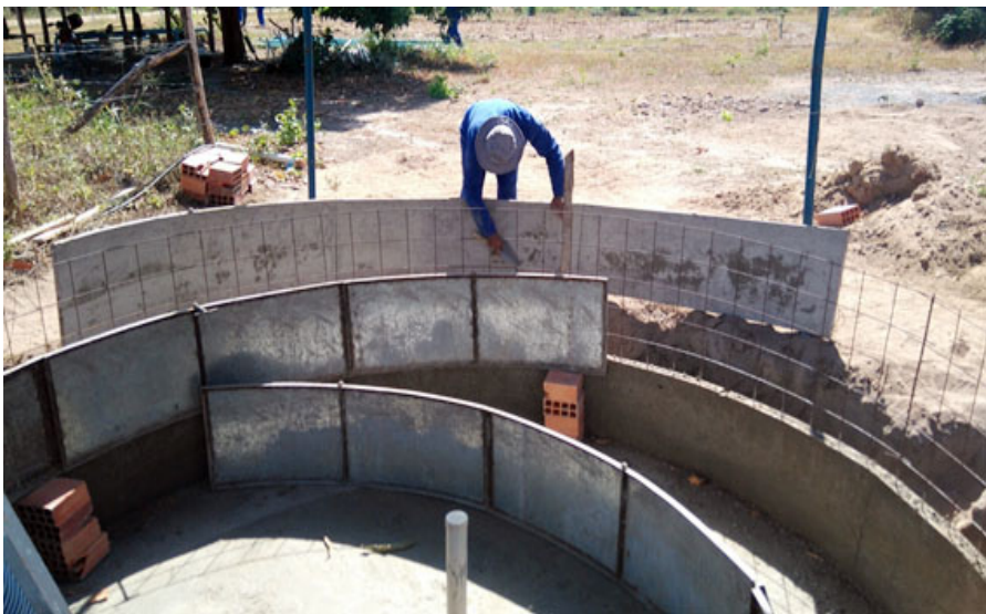
Figura 29. Estrutura de escoramento no enchimento da primeira seção da parede lateral.
