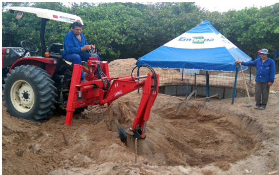
Figura 11. Escavação de forma mecânica.
