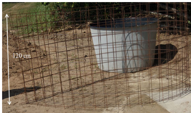
Figura 21. Tela de ferro cortada em duas peças de 6,0 m x 1,2 m.
