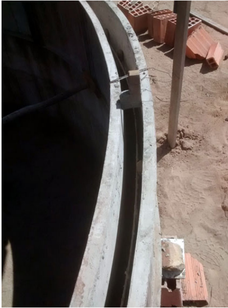
Figura 6. Disposição no terreno das formas internas e externas após a montagem.
