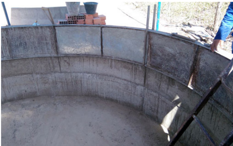
Figura 33. Montagem das formas para construção da terceira seção da parede lateral.
