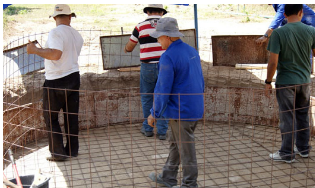
Figura 22. Distribuição das duas telas de ferro (6,0 m x 1,2 m) após a colocação da forma externa.
