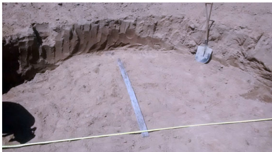
Figura 9. Medição para locação do tanque no terreno.
