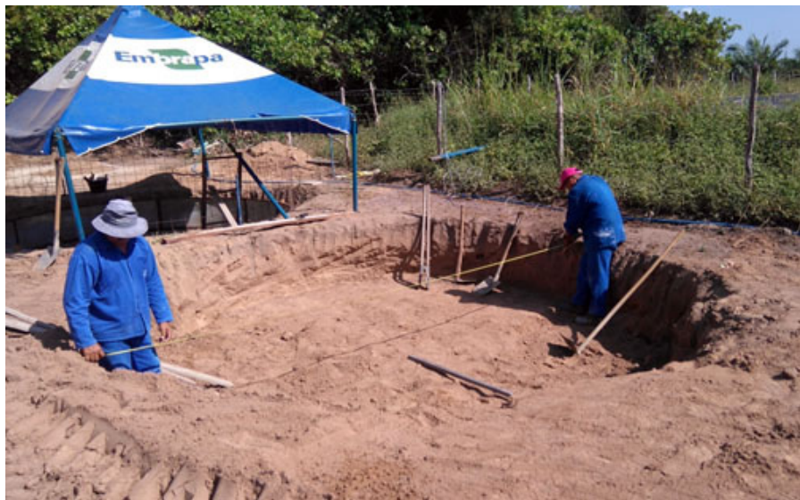
Figura 10. Escavação de forma manual.
