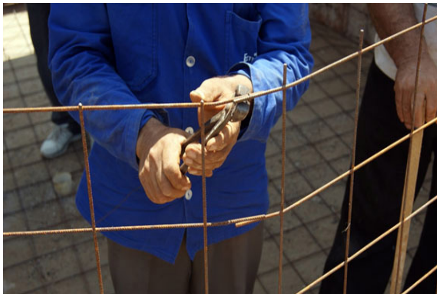
Figura 23. União das duas telas de ferro (6,0 m x 1,2 m).
