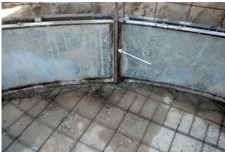
Figura 24. Pedacos de madeira na junção das peças da forma interna.
