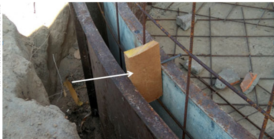
Figura 26. Detalhe do pequeno calço de madeira entre as formas externa e interna para melhor ajuste do espaçamento entre as mesmas após a montagem.
