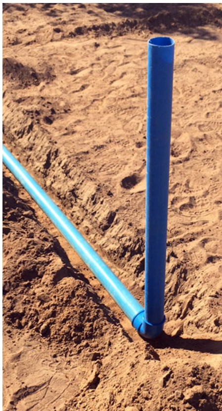
Figura 13. Disposição da tubulação de drenagem.
