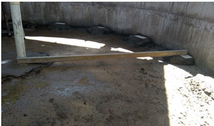
Figura 37. Declividade do piso do tanque em direção ao centro.
