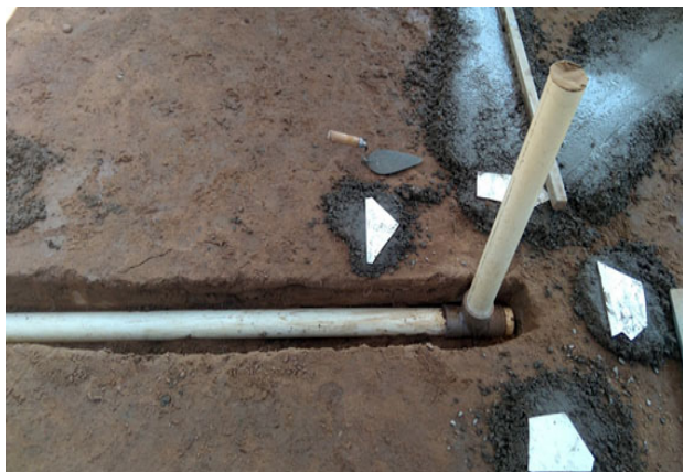
Figura 15. Início da construção do contrapiso em nível. Em detalhe, o sistema de drenagem com uso de material reciclado.
