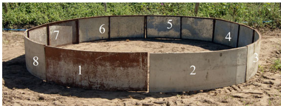
Figura 4. União das oito formas internas, formando um círculo de 378 cm de diâmetro.
