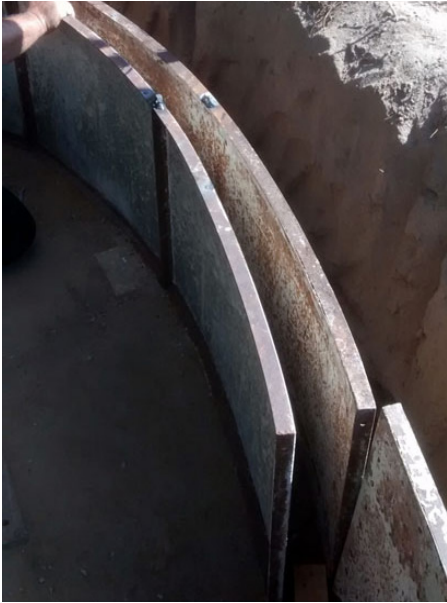
Figura 5. Montagem das formas internas e externas para formação dos círculos de 378 cm e 388 cm, respectivamente.
