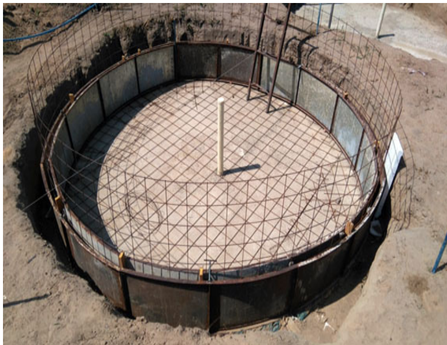
Figura 25. Distribuição final das telas de ferro (6,0 m x 1,2 m) e das formas externa e interna.
