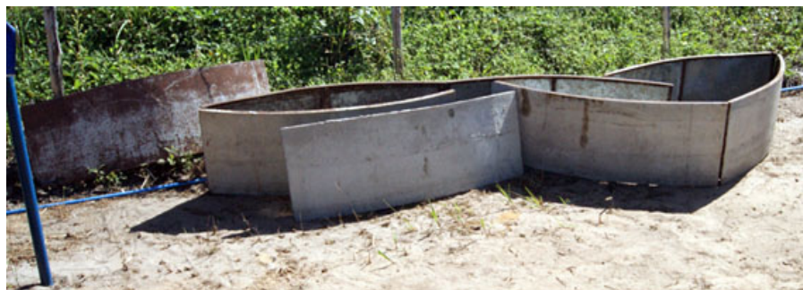
Figura 3. Formas internas antes da montagem para formação do círculo.
