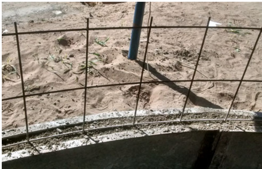
Figura 32. Segunda seção da parede lateral do tanque pouco antes da desmontagem das formas.
