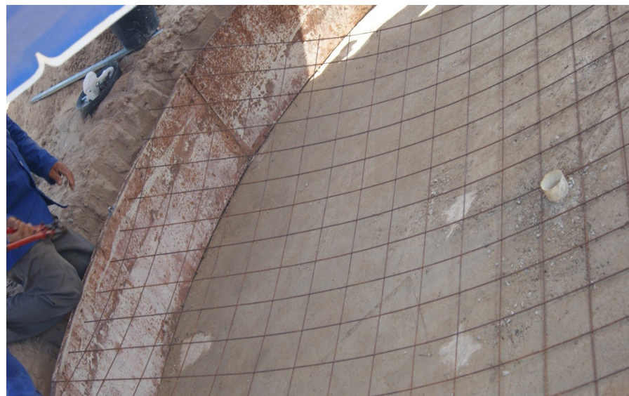
Figura 18. Corte da tela de ferro sobre o contrapiso.
