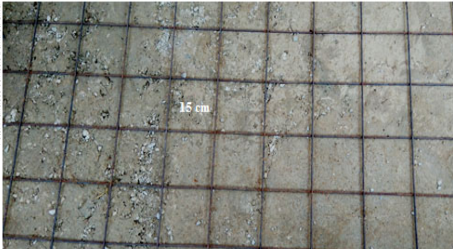
Figura 8. Espaçamento do ferro de 15 cm.
