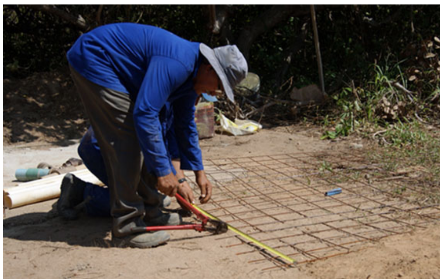
Figura 20. Início do corte no sentido longitudinal da tela de 6,0 m x 2,4 m.
