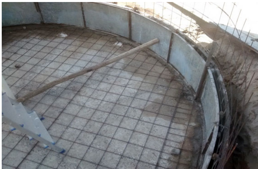
Figura 30. Desmontagem das formas após a finalização da construção da primeira seção e do piso do tanque.
