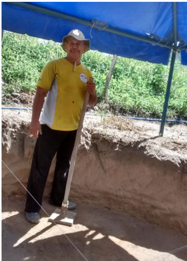
Figura 14. Operação de compactação com malho.
