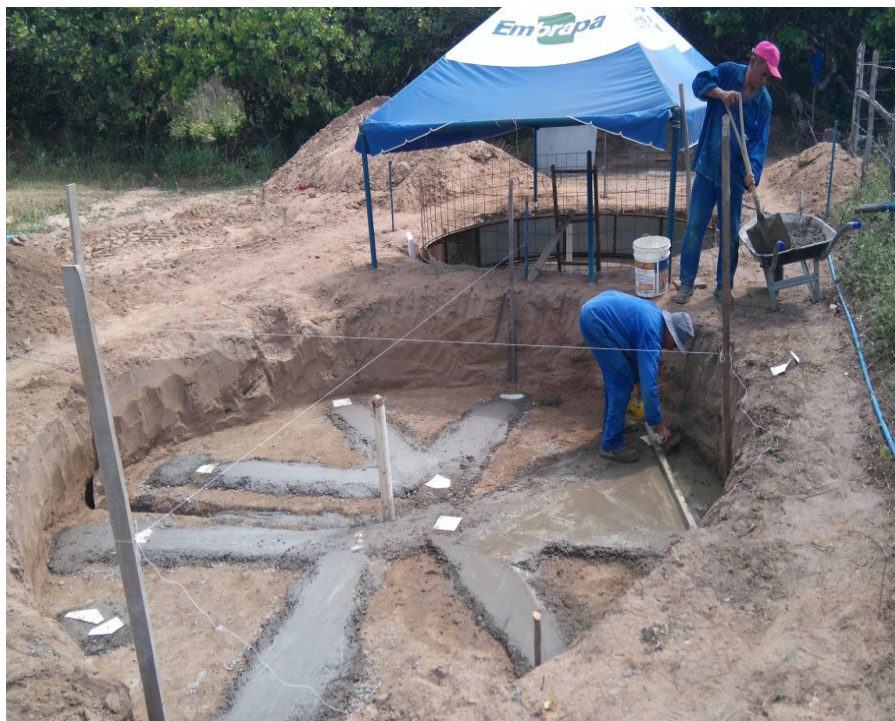
Figura 16. Finalização da construção do contrapiso em nível.
