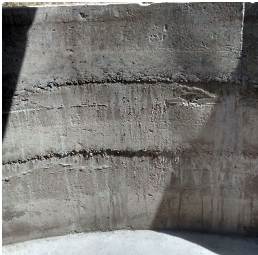
Figura 38. Parede lateral após a retirada das formas.
