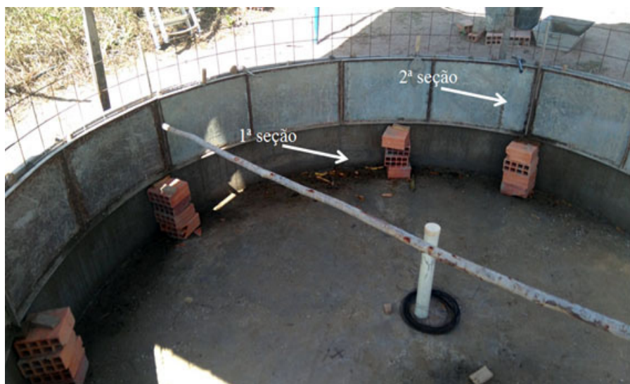
Figura 31. Estrutura de escoramento no enchimento da segunda seção da parede lateral.
