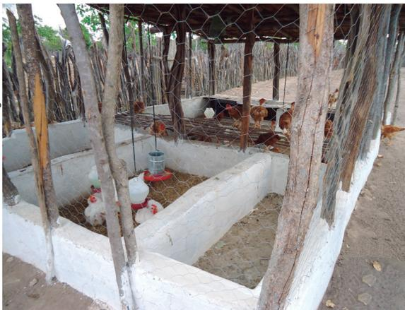
**Figura 1.** Aviário com rodapé de taipa, paredes de estacas e tela, com chão batido.
