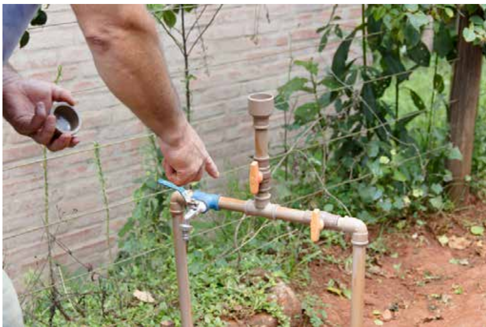
Figura 11. Clorador de fácil montagem e baixo custo.
