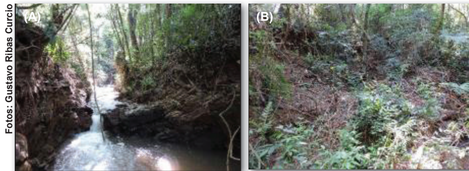
Figura 13. Visão geral do segmento 2, como ressaltado topográfico (A) e erosão em talude por fluxo hídrico externo (B).
