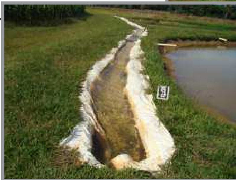
Canal de abastecimento de água por gravidade.
