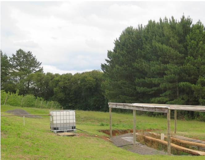
Fig. 4. Exemplo de tanque pulmão em uso para coleta de excessos em época de grande volume de efluente para uso nos períodos de baixos volumes ou escassez."
