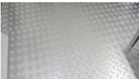
**Figura 16.** Piso em alumínio antiderrapante.
