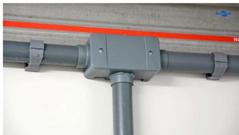
**Figura 15.** Tubulação para fiação elétrica.
