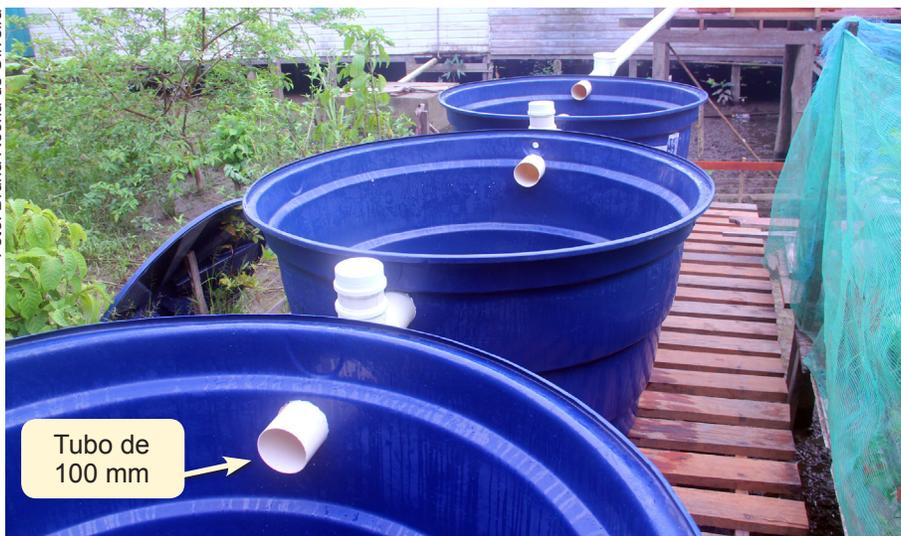
**Figura 12.** Interligação das caixas por meio dos tubos.
