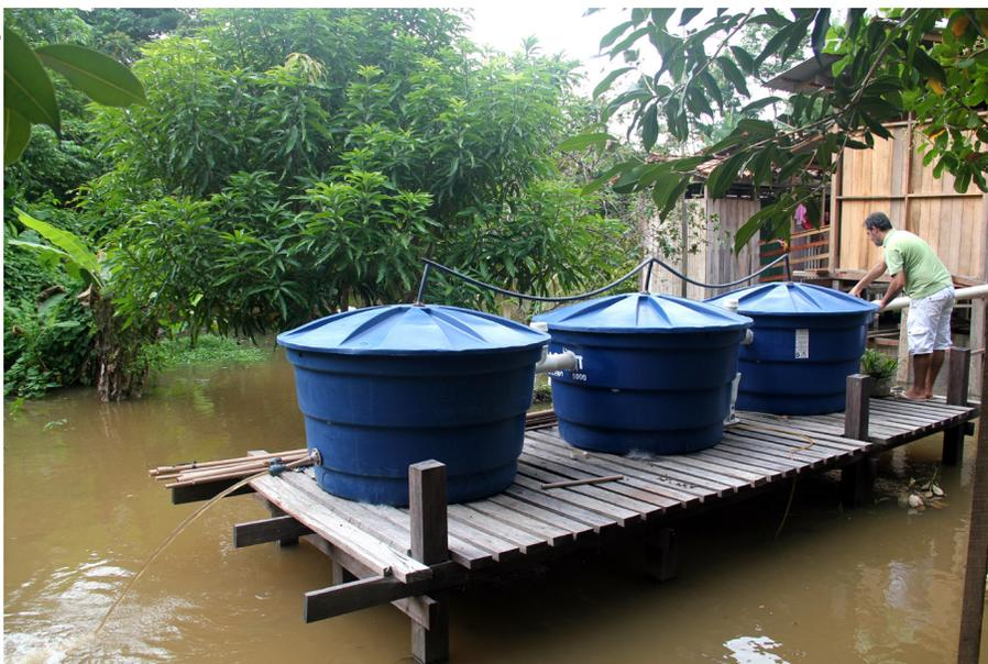
**Figura 2.** Fossa séptica biodigestora instalada na Ilha das Cinzas, Gurupá, PA, com três caixas de polietileno sobre o tablado de madeira, que é parecido com um jirau.
