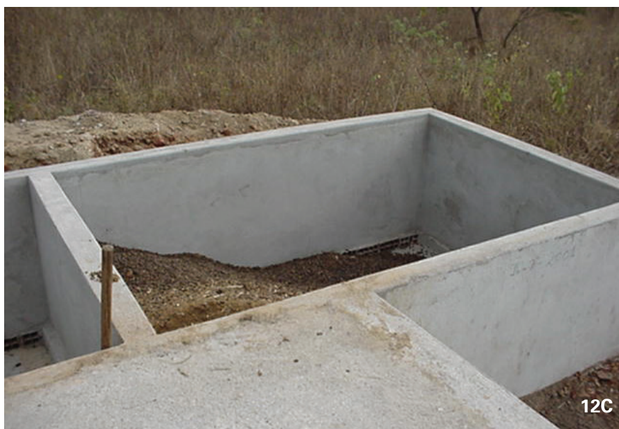
Figura 12. Transporte do esterco e armazenamento em esterqueira de alvenaria.
