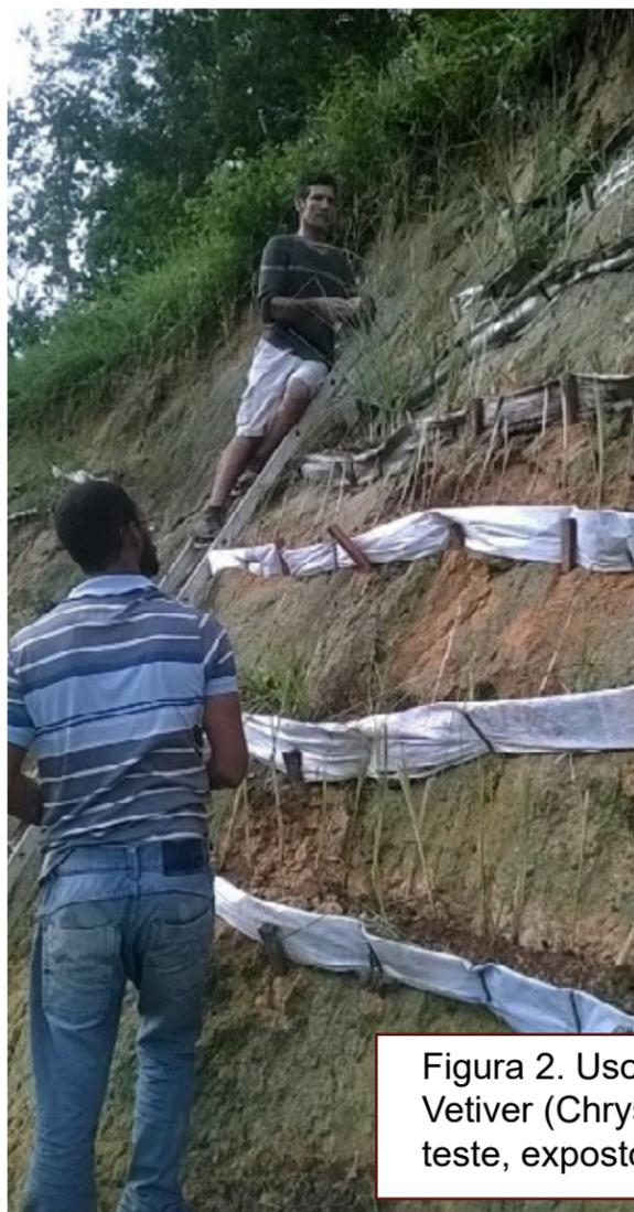
Figura 2. Uso de Bioengenharia de solos com Plantio de Vetiver (*Chrysopogon zizanioides* (L.) Roberty) em talude teste, exposto no CECA.
