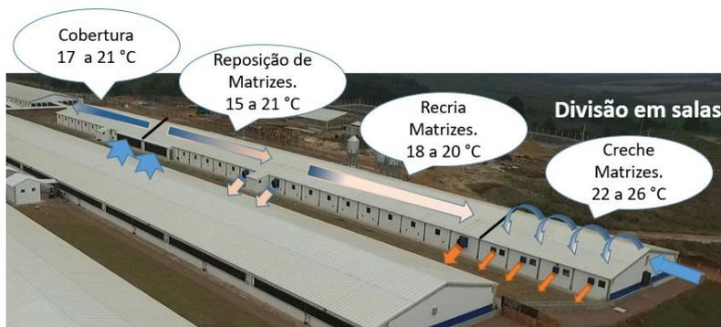
Figura 4. Esquema de ventilação e temperatura do setor da multiplicadora.
