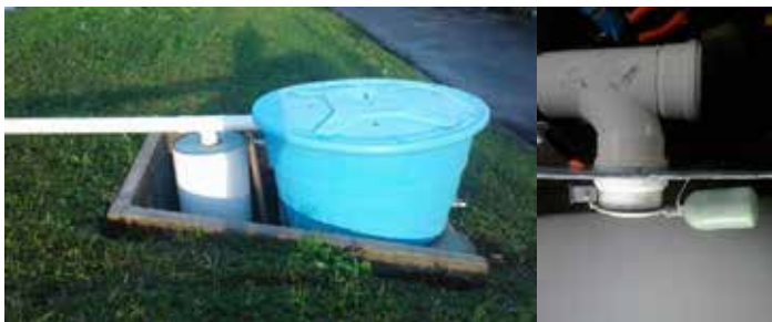
Figura 10. Sistema de captação de água da chuva do telhado das edificações, com eliminação do volume inicial coletado.
