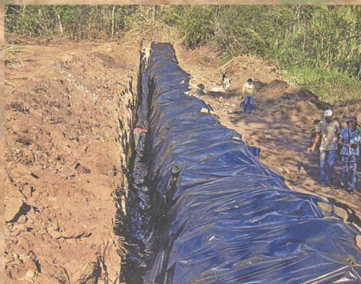
3. Plástico estendido (septo impermeável/parede)
