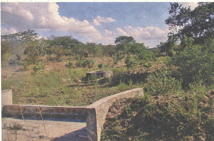
O custo de uma unidade de **Barragem subterrânea** varia de acordo com o seu comprimento e a profundidade do solo ao longo da parede, além do tamanho e tipo de sangradouro e a existência ou não de poço.
