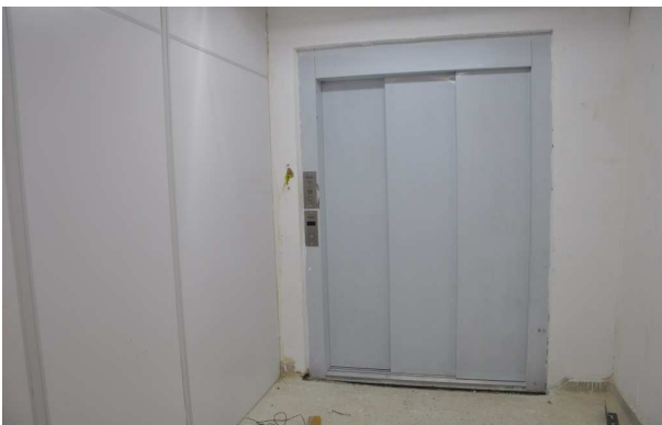
Figura 48. Visão frontal da porta do elevador com capacidade de carga de 1,5 tonelada.
