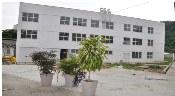
Figura 42. Vista frontal do novo prédio do LASP.
