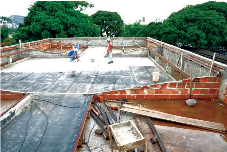
Foto 43 - Vista da cobertura do novo prédio do LASP.
