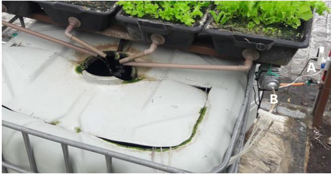
**Figura 6.** Temporizador (*timer*) analógico (A) e compressor de ar eletromagnético e mangueiras de silicone (B), conduzindo o ar à água da caixa de criação dos peixes.
