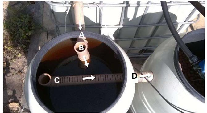
**Figura 7.** Vista interna do filtro decantador. A) entrada da água vinda da caixa de criação dos peixes. B) “T” instalado na entrada para direcionar a água para a base de filtro (Foi utilizado um tubo 50 mm de diâmetro e 60 cm de comprimento com cotovelo na extremidade posterior). C) tubo 50 mm com 40 cm de comprimento contendo fendas voltadas para cima e um cotovelo na extremidade oposta. D) flange instalado na saída em direção ao filtro biológico.
