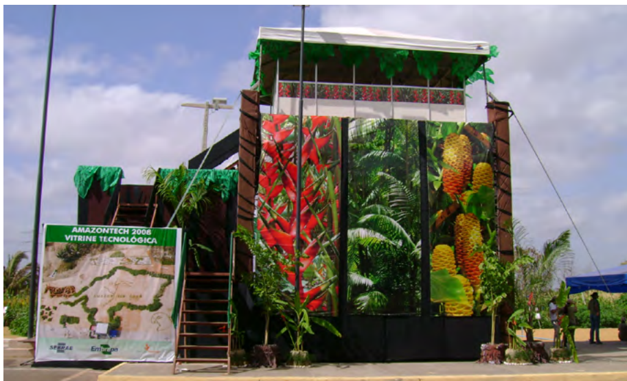
Estrutura metálica de camarote no mirante.
