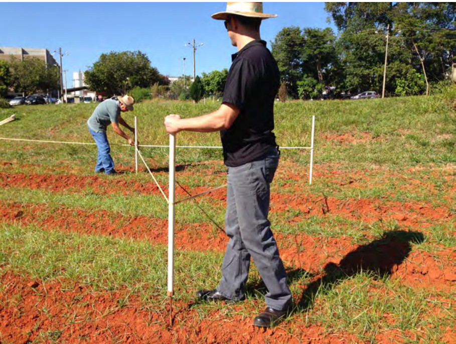
Implantação do segundo canto com a sobreposição do nº 12 ao nº 0.
