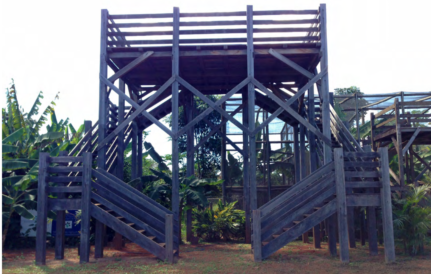
Detalhe das duas escadas do mirante.
