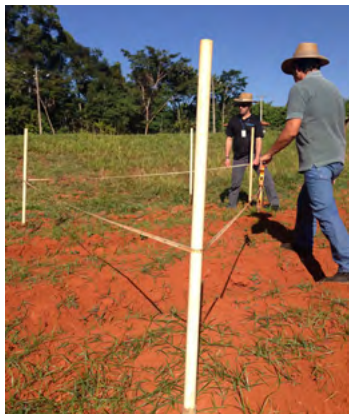
Posicionamento da trena, estendendo-a em direção ao nº 0.
