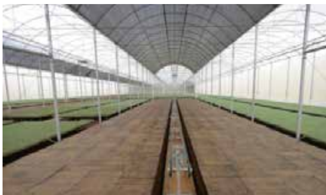
Figura 11. Corredores internos com o posicionamento de esteira para distribuição de bandejas.
