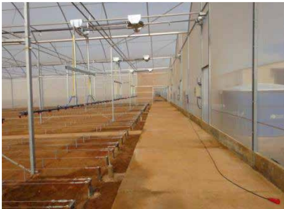
Figura 12. Calçada frontal que permite a ligação entre os corredores internos e o trânsito de empilhadeiras.
