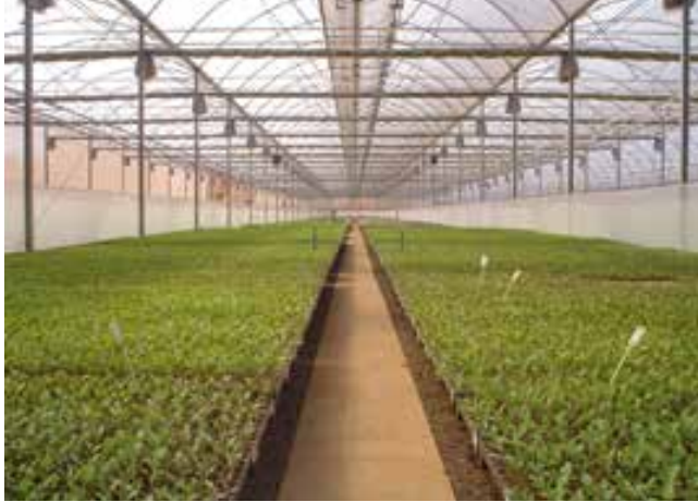
Figura 4. Estrutura interna de um viveiro, com destaque para o corredor cimentado.
