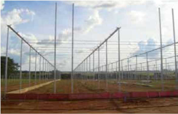
Figura 4. Construção do viveiro: estruturas em aço carbono galvanizado.
