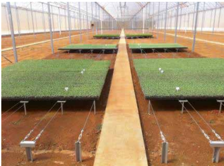
Figura 8. Bancadas construídas em sistemas de “latada” com arame liso, apoiadas sobre estruturas metálicas.
