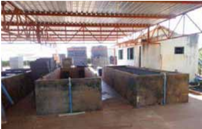
Figura 22. Galpão de lavagem e desinfecção de bandejas de bandejas: vista dos tanques de imersão.
