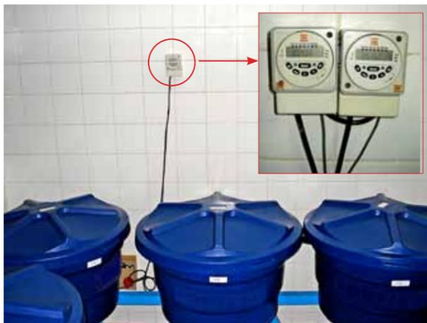
**Figura 6.** Conjunto de caixas e na parede, no detalhe, o "timer" de controle do horário, frequência e tempo em minutos de irrigação.
