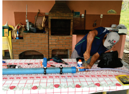
Figura 13. Colagem e fixação do cap de entrada na extremidade do pulmão.
