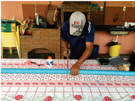
Figura 4. Corte da tubulação de irrigação na medida determinada pelo projeto.
