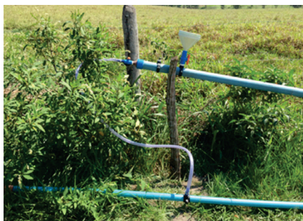
Figura 17. Detalhe da estrutura de entrada do sistema.
