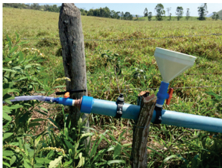
Figura 18. Detalhe da estrutura de entrada do sistema.
