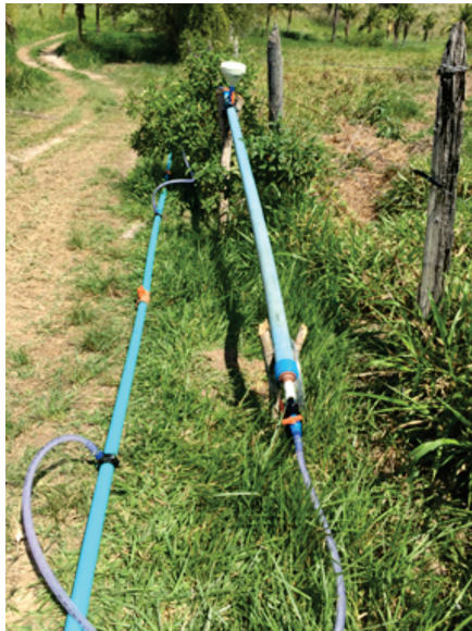
Figura 16. Pulmão instalado no local definitivo.
