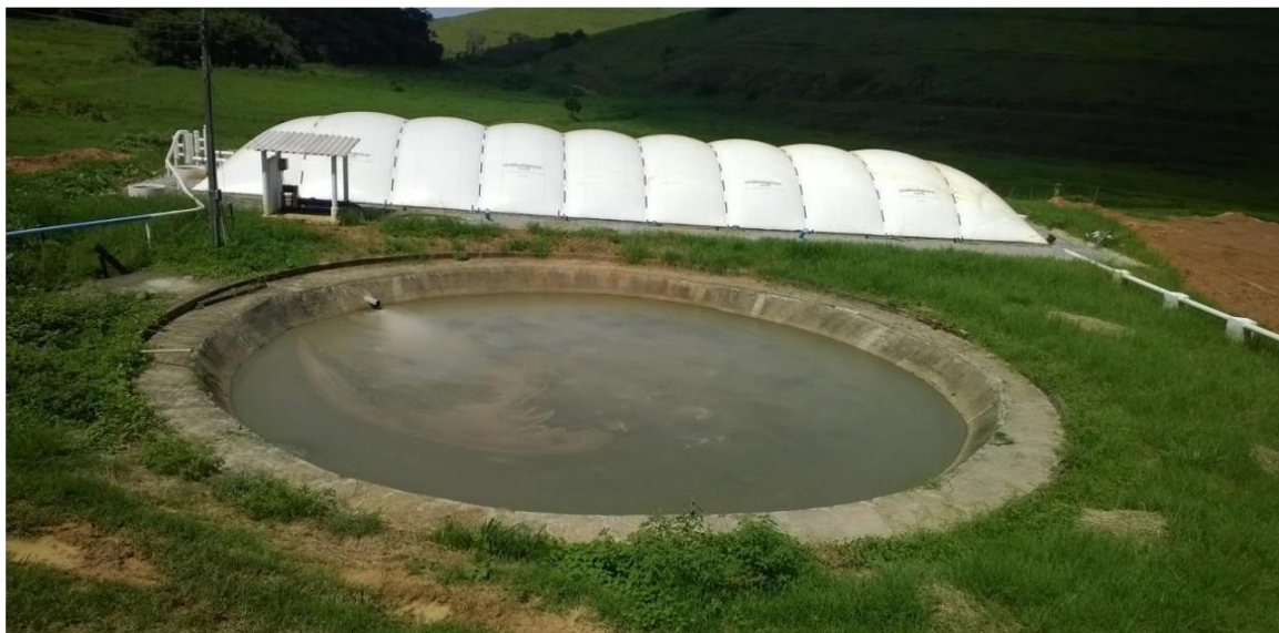
Figura 1: Biodigestor, modelo canadense, e lagoa de estabilização instalados no campo experimental da Embrapa Gado de Leite.
