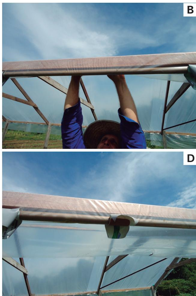
**Figura 5.** Procedimento para a colocação das braçadeiras (grampos) de PVC. Esticar o plástico (A), puxar o plástico para cima (B), manter o plástico esticado e prender o grampo com a tira plástica (C), grampo fixado (D).
