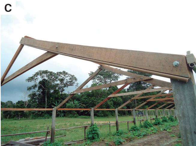
**Figura 3.** Cano de PVC fixado na perna-manca (A), sob a lateral da casa (B) e na cabeceira (C).
