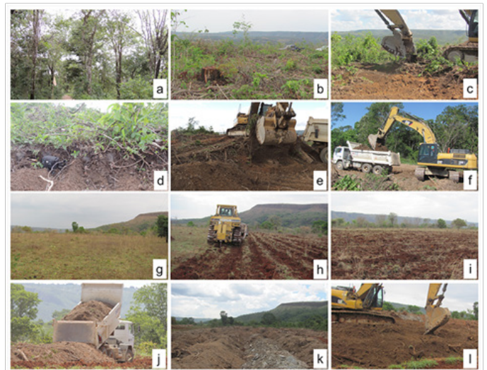
Figura 2. Etapas da transposição da camada superficial do solo (CSS) de Floresta Estacional Decidual, Região da Fercal, Distrito Federal, Brasil. a: floresta antes da supressão; b: floresta após a supressão; c: remoção da CSS por uma retroescavadeira; d: superfície de solo removida, 30 cm; e: pilha de solo com serrapilheira, fragmentos de raiz, caule, plantas inteiras e sementes; f: retroescavadeira dispondo o solo no caminho; g: a área de deposição era uma pastagem com baixa regeneração natural; h: área de deposição escarificada por um trator esteira; i: solo descompactado e livre da dominância de gramíneas; j: deposição da CSS; k: superfície da área de deposição; l: retroescavadeira nivelando a CSS na espessura de 20 cm.
