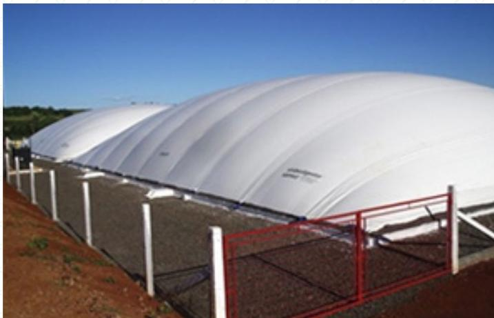
Figura 5. Biodigestor modelo lagoa coberta.
