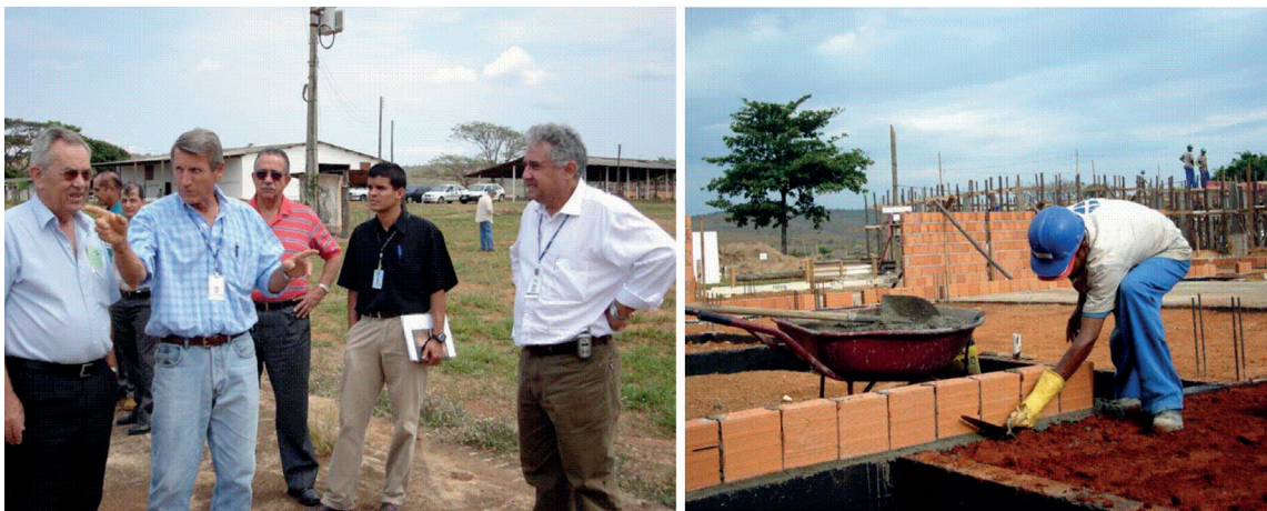
Fig. 40. Construção do CTZL.
