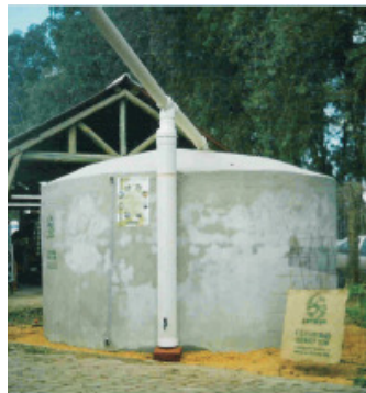
Fig. 2. Cisterna de alvenaria.
