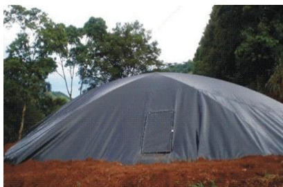
Fig. 4. Cisterna de manta de PEAD.
