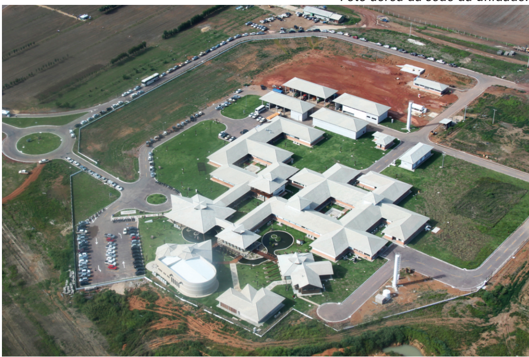
Foto aérea da sede da unidade.
